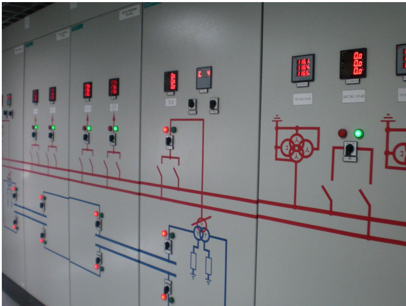
Рисунок 9 – Мнемосхема и центральная сигнализация
