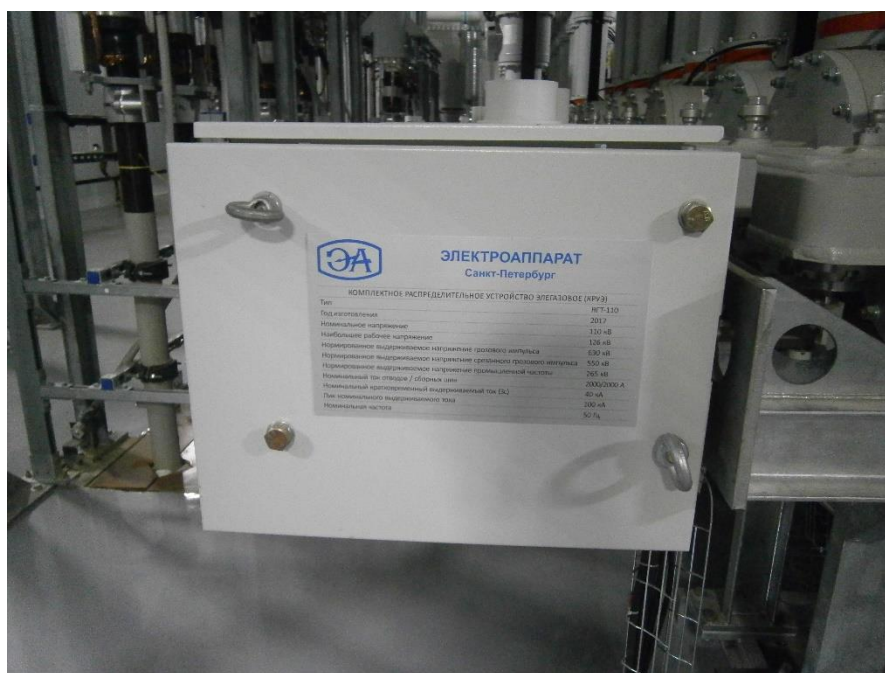
Рисунок 3 – Помещение КРУЭ 110 кВ типа ЯГТ-110 «Электроаппарат
