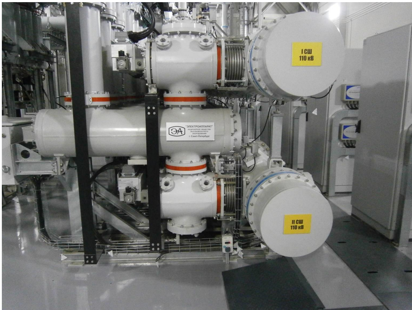
Рисунок 4 – Модуль КРУЭ 110 кВ типа ЯГТ-110 «Электроаппарат»
