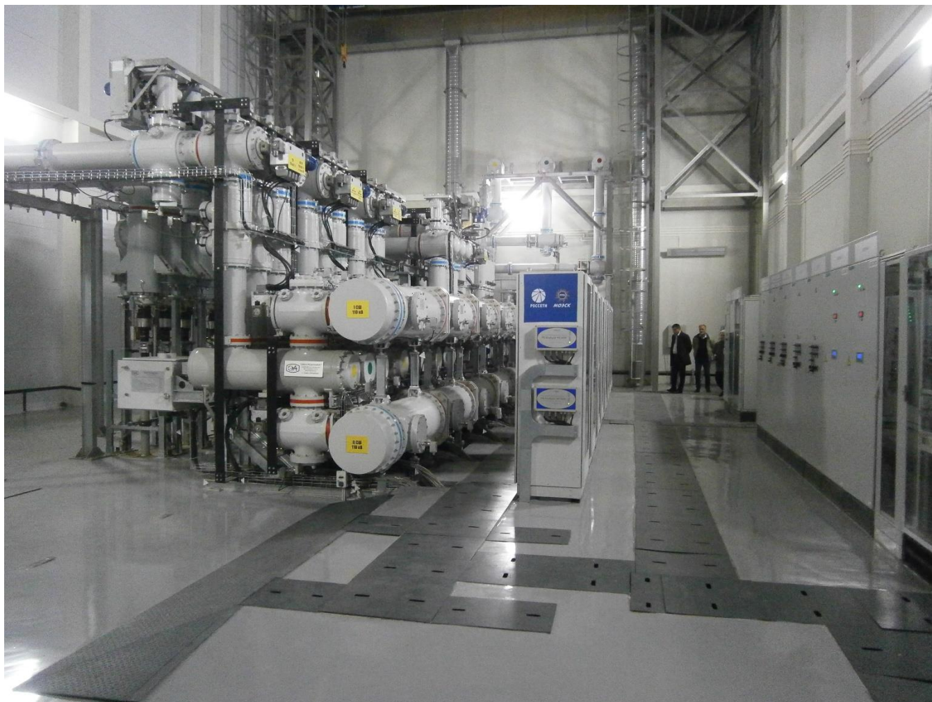
Рисунок 3 – Помещение КРУЭ 110 кВ типа ЯГТ-110 «Электроаппарат
