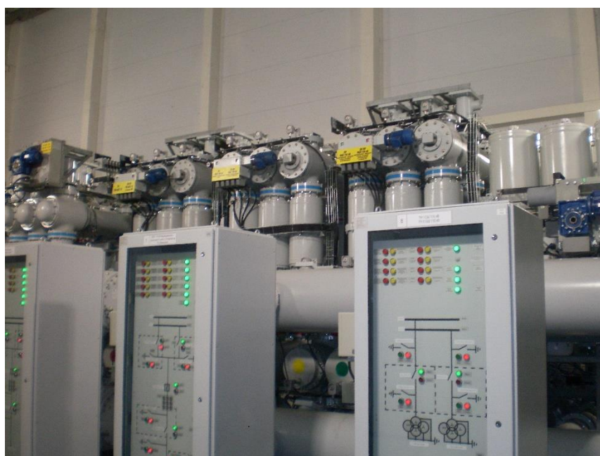
Рисунок 5 – Шкафы управления модулями КРУЭ 110 кВ типа ЯГТ-110 «Электроаппарат»
