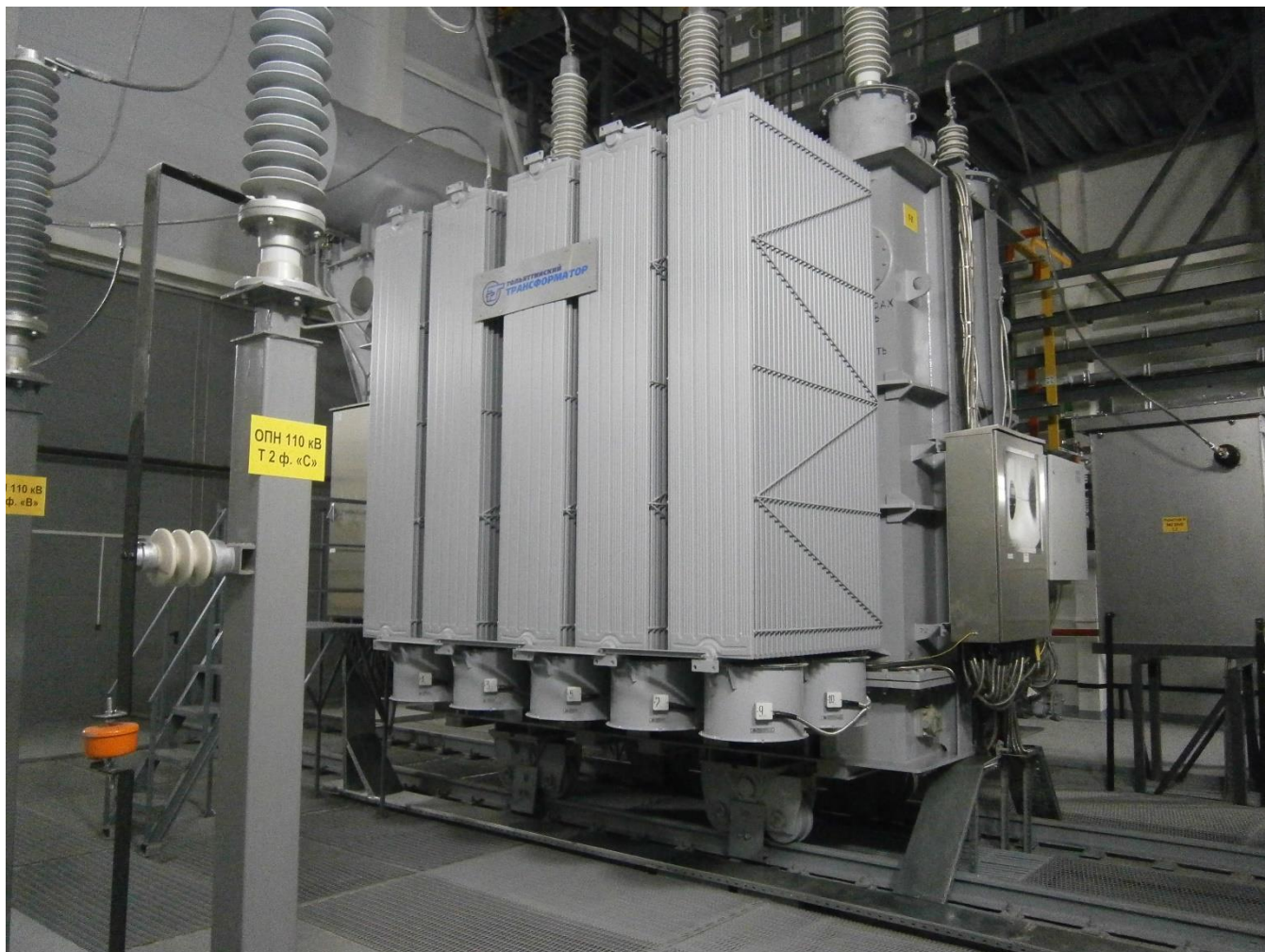
Рисунок 2 – Камера трансформатора Т-2 (Т-1) типа ТРДН-80000/110
