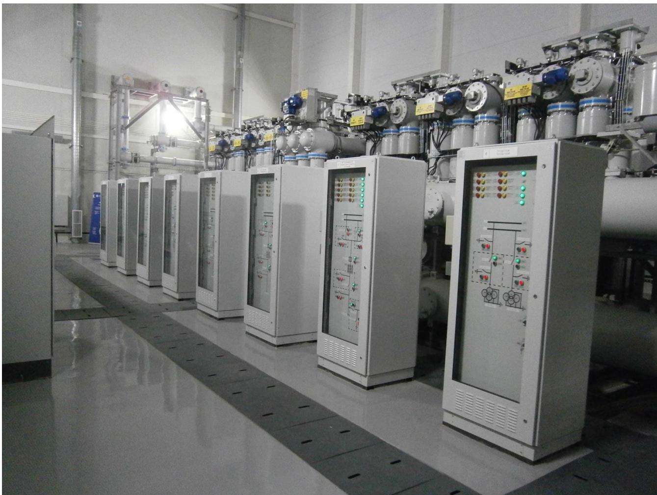
Рисунок 5 – Шкафы управления модулями КРУЭ 110 кВ типа ЯГТ-110 «Электроаппарат»
