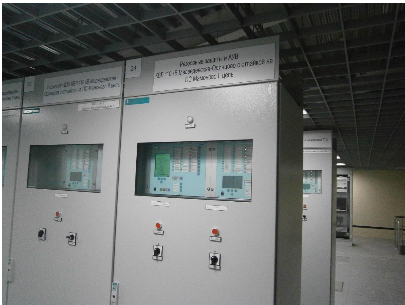
Рисунок 8 – Шкафы защит ЭКРА
