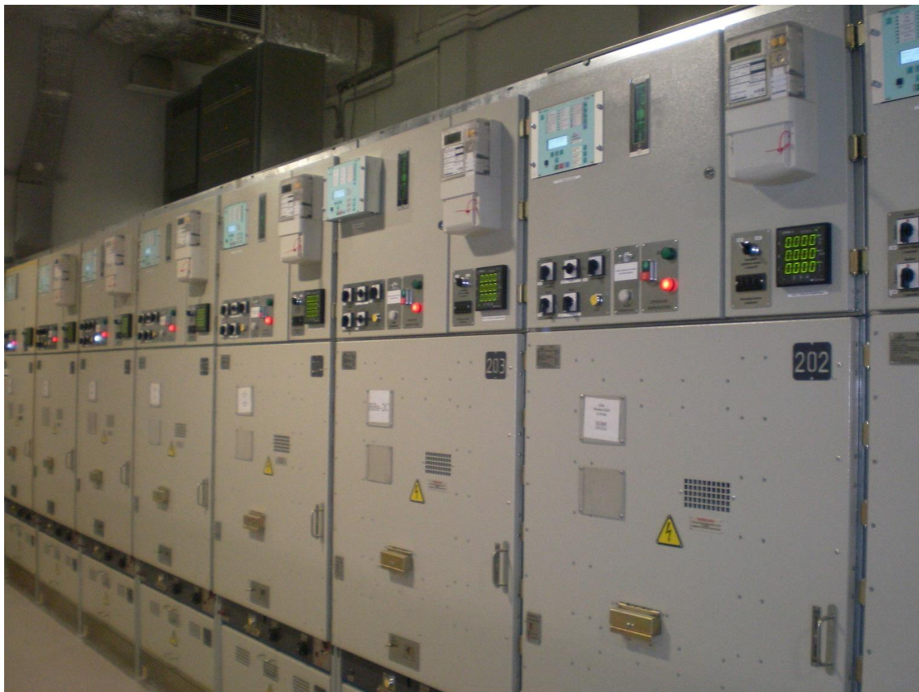
Рисунок 6 – КРУ 20 кВ (ячейки секции 1-3)
