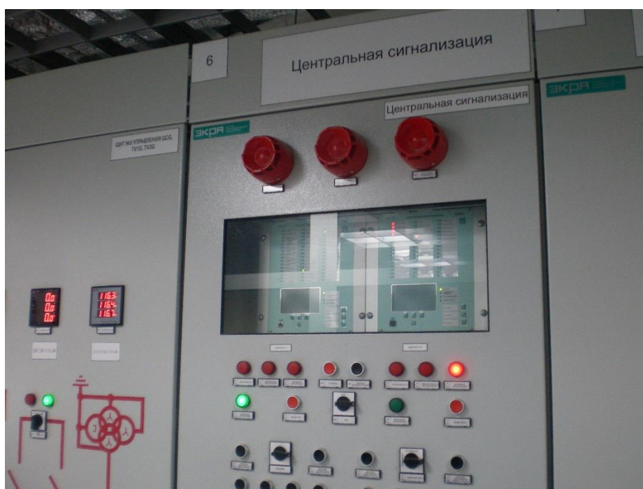
Рисунок 9 – Мнемосхема и центральная сигнализация
