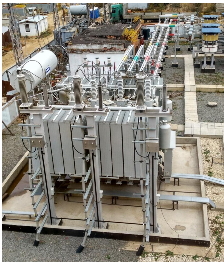
Рис. 6.7. Установка трансформатора 80 МВА
