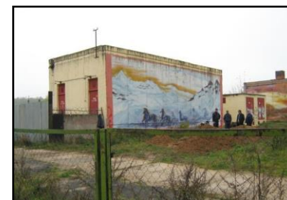
РТТ ЗАО «Октябрьская электросеть»
