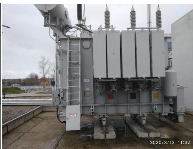
Рисунок 2 – Трансформаторы Т-1 (Т-2) 110/35/10 кВ по 63 МВА каждый
