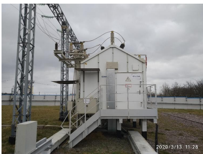
Рисунок 5 – КРУМ-35 кВ, портал и отходящая ВЛ 35 кВ
