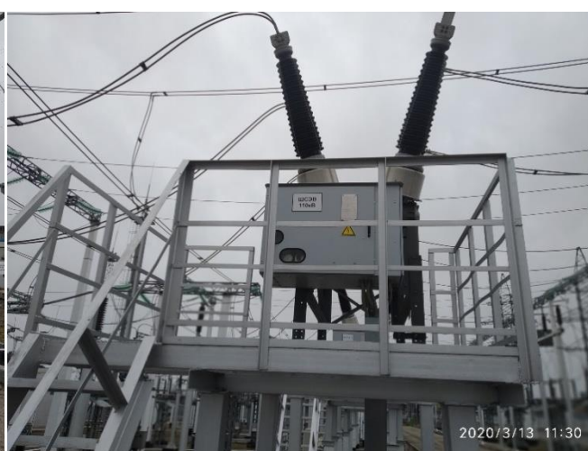
Рисунок 8 – ОРУ-110 кВ, элегазовые выключатели напряжением 110 кВ
