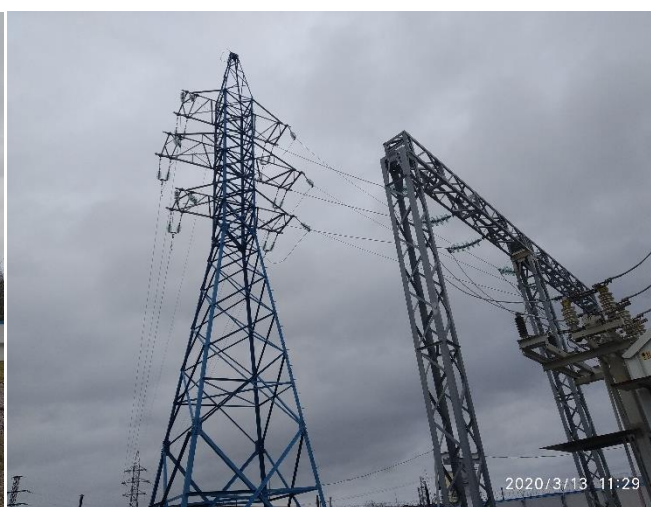
Рисунок 5 – КРУМ-35 кВ, портал и отходящая ВЛ 35 кВ
