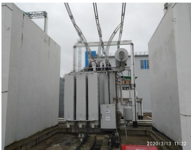
Рисунок 4 – Трансформатор линейный регулировочный трехфазный 40 МВА ВДТ-1 и ВДТ-2
