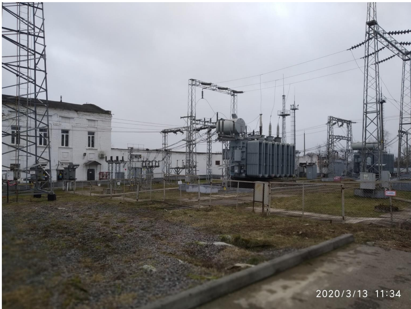
Рисунок 10 – старое ОРУ-110 кВ, демонтаж основного оборудования
