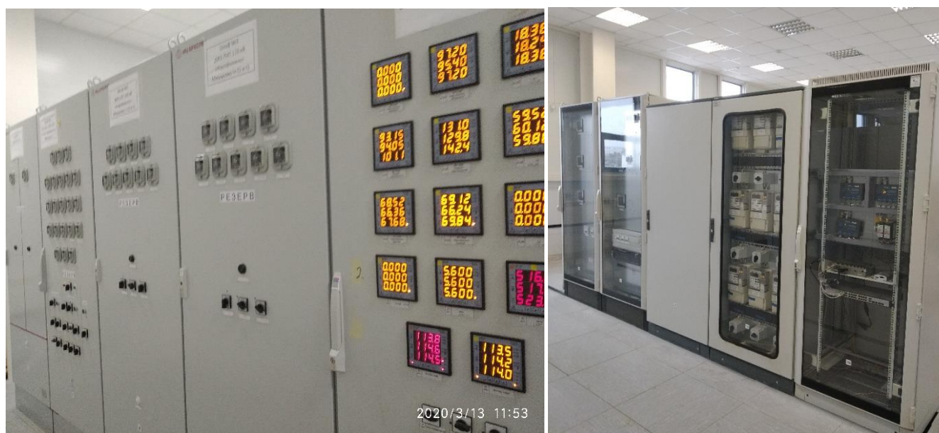
Рисунок 7 – ОПУ, панели РЗА, управления и центральной сигнализации
