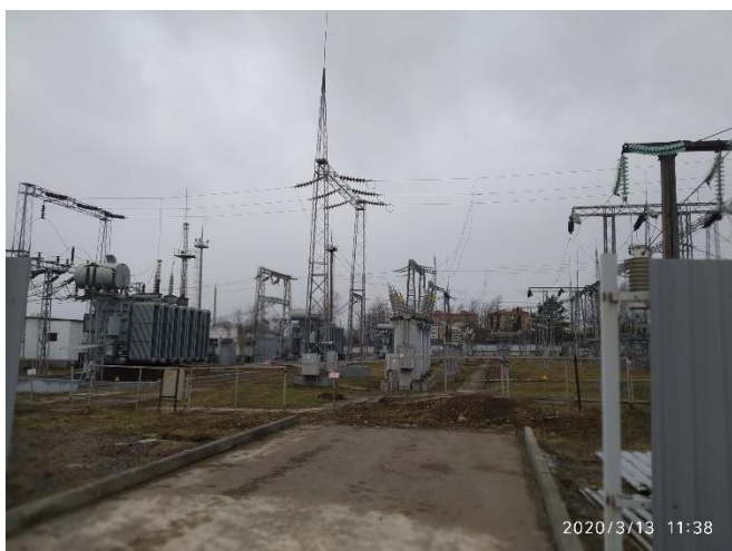
Рисунок 10 – старое ОРУ-110 кВ, демонтаж основного оборудования
