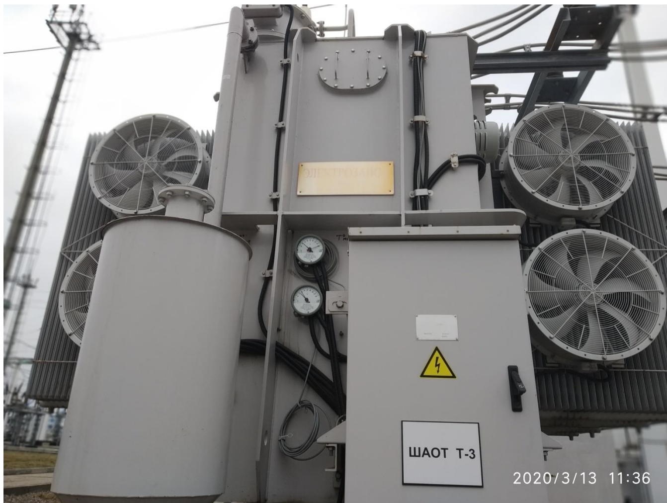
Рисунок 3 – Трансформатор Т-3 110/10-10 кВ 63 МВА
