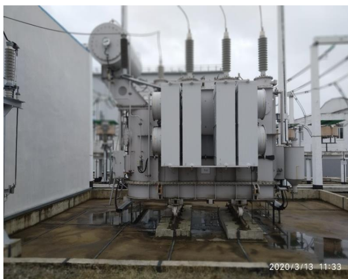
Рисунок 3 – Трансформатор Т-3 110/10-10 кВ 63 МВА
