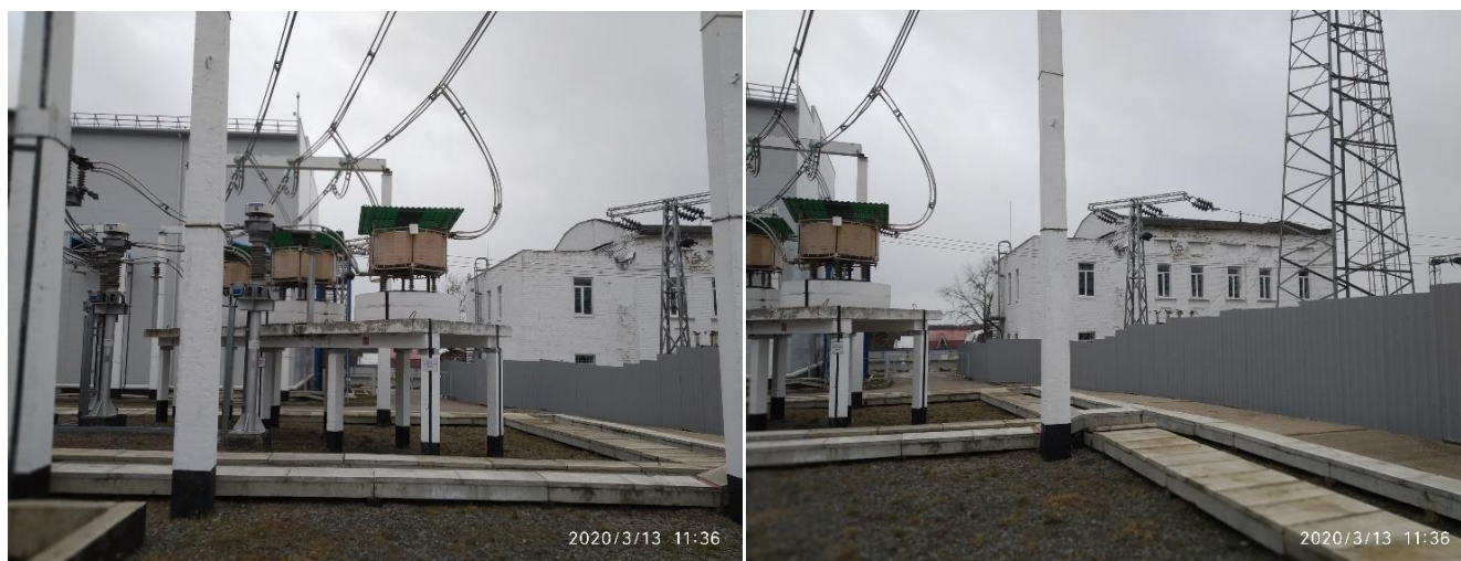
Рисунок 9 – Токоограничивающие трехфазные реакторы 10 кВ (4 шт.)
