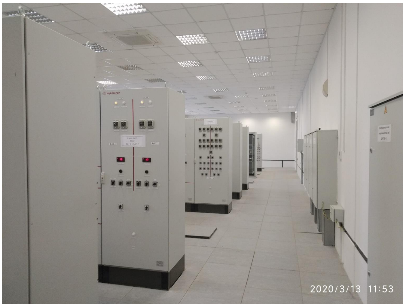
Рисунок 7 – ОПУ, панели РЗА, управления и центральной сигнализации
