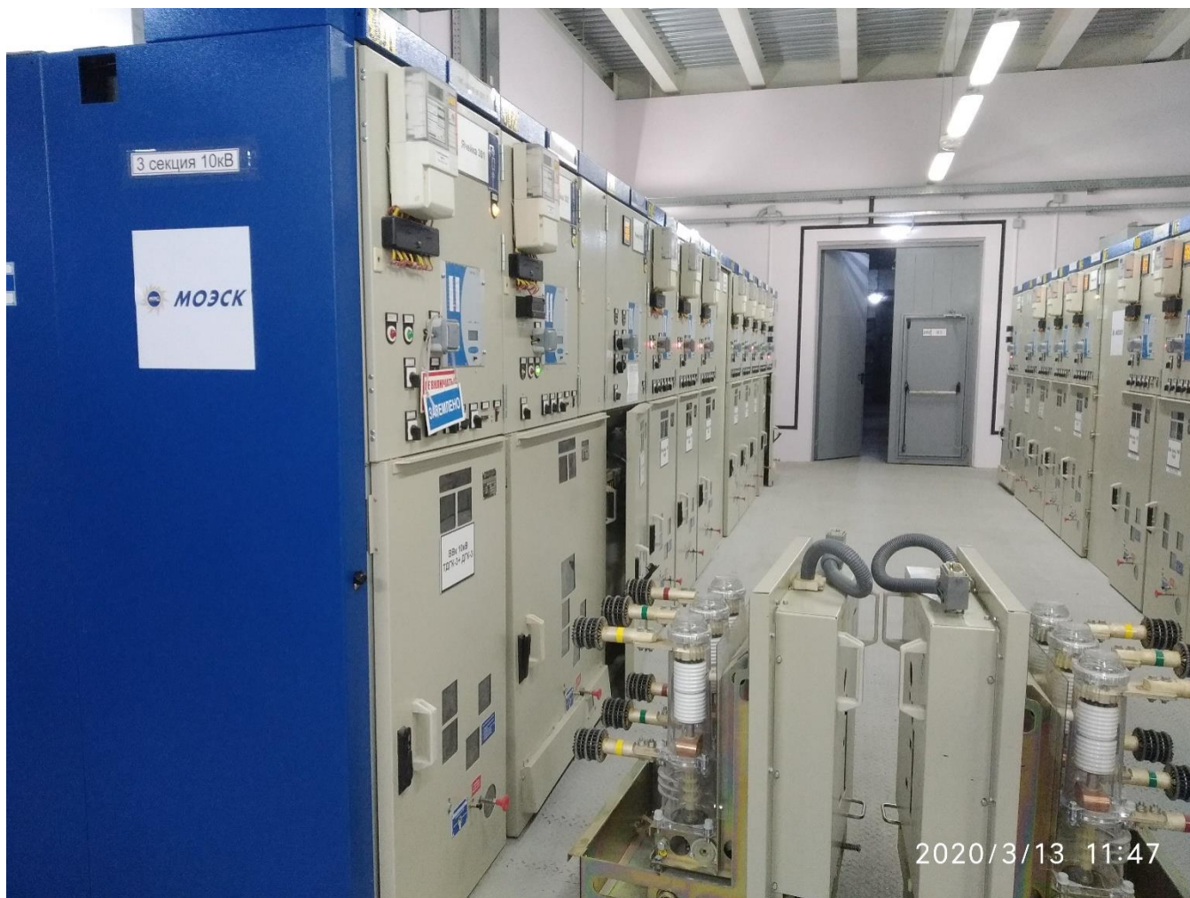
Рисунок 6 – КРУ 10 кВ (ячейки секции 1-3)
