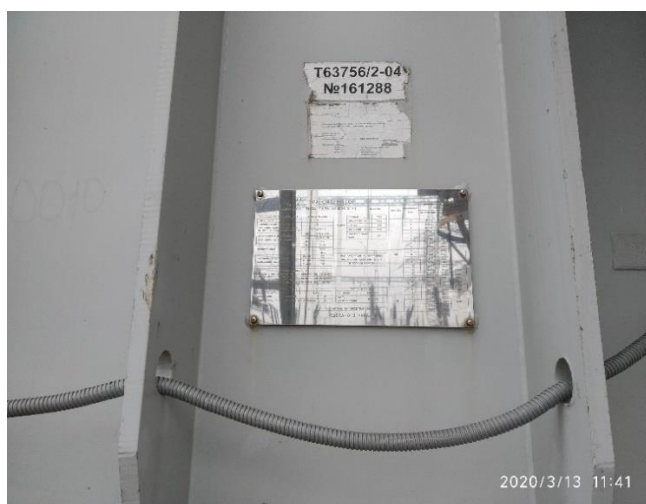
Рисунок 2 – Трансформаторы Т-1 (Т-2) 110/35/10 кВ по 63 МВА каждый
