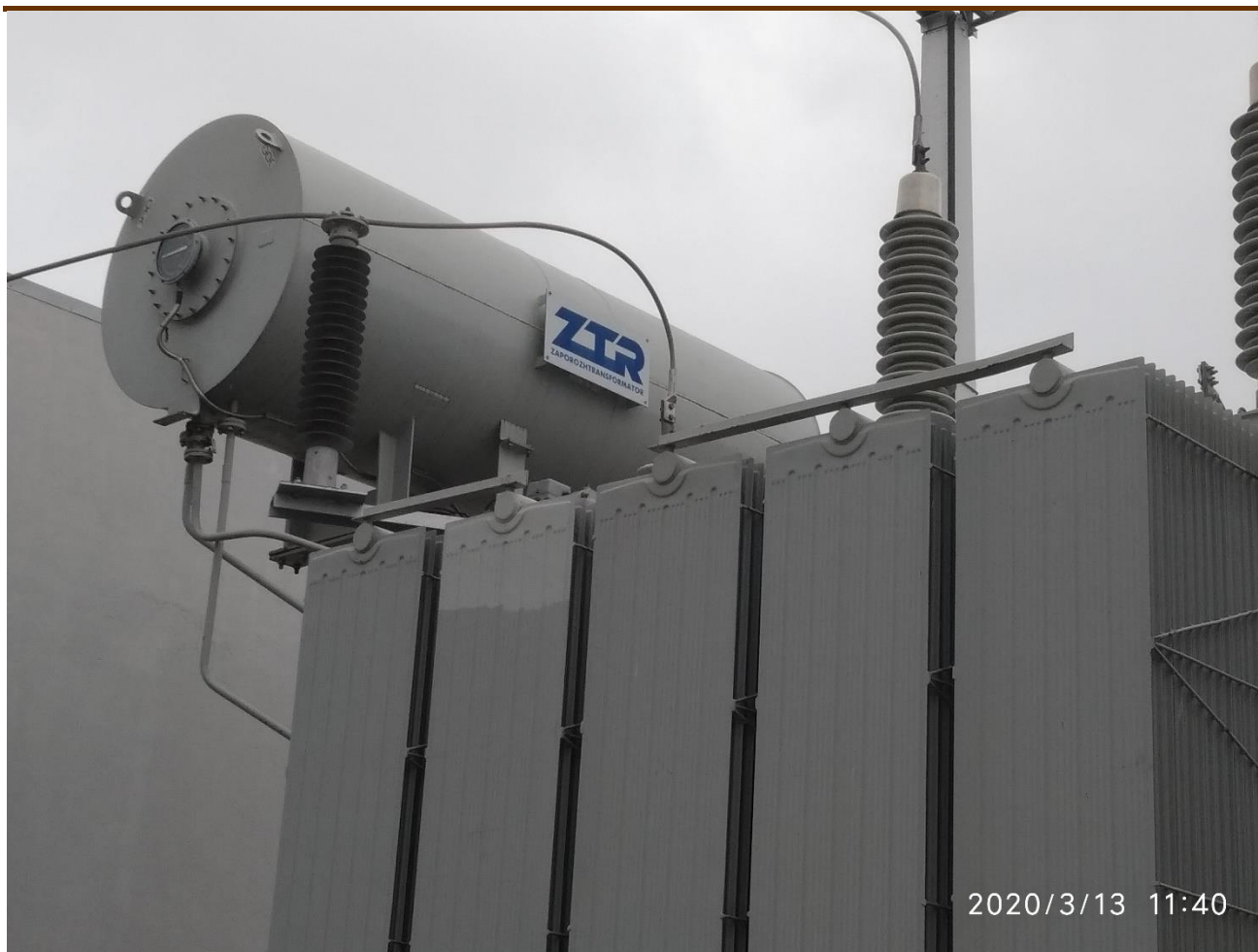
Рисунок 2 – Трансформаторы Т-1 (Т-2) 110/35/10 кВ по 63 МВА каждый
