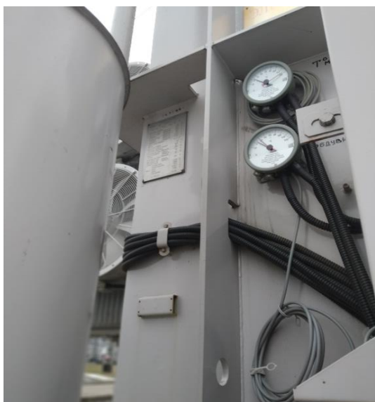
Рисунок 3 – Трансформатор Т-3 110/10-10 кВ 63 МВА
