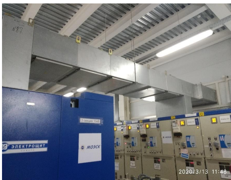
Рисунок 6 – КРУ 10 кВ (ячейки секции 1-3)
