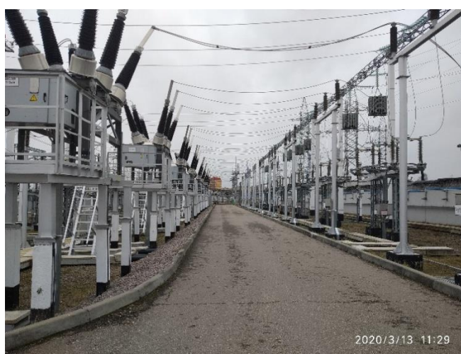
Рисунок 8 – ОРУ-110 кВ, элегазовые выключатели напряжением 110 кВ
