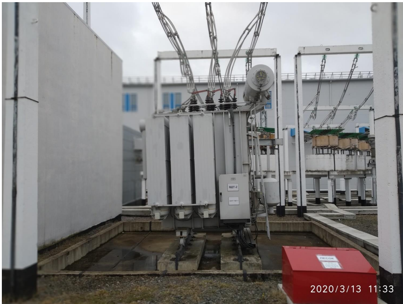
Рисунок 4 – Трансформатор линейный регулировочный трехфазный 40 МВА ВДТ-1 и ВДТ-2
