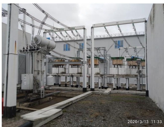
Рисунок 4 – Трансформатор линейный регулировочный трехфазный 40 МВА ВДТ-1 и ВДТ-2
