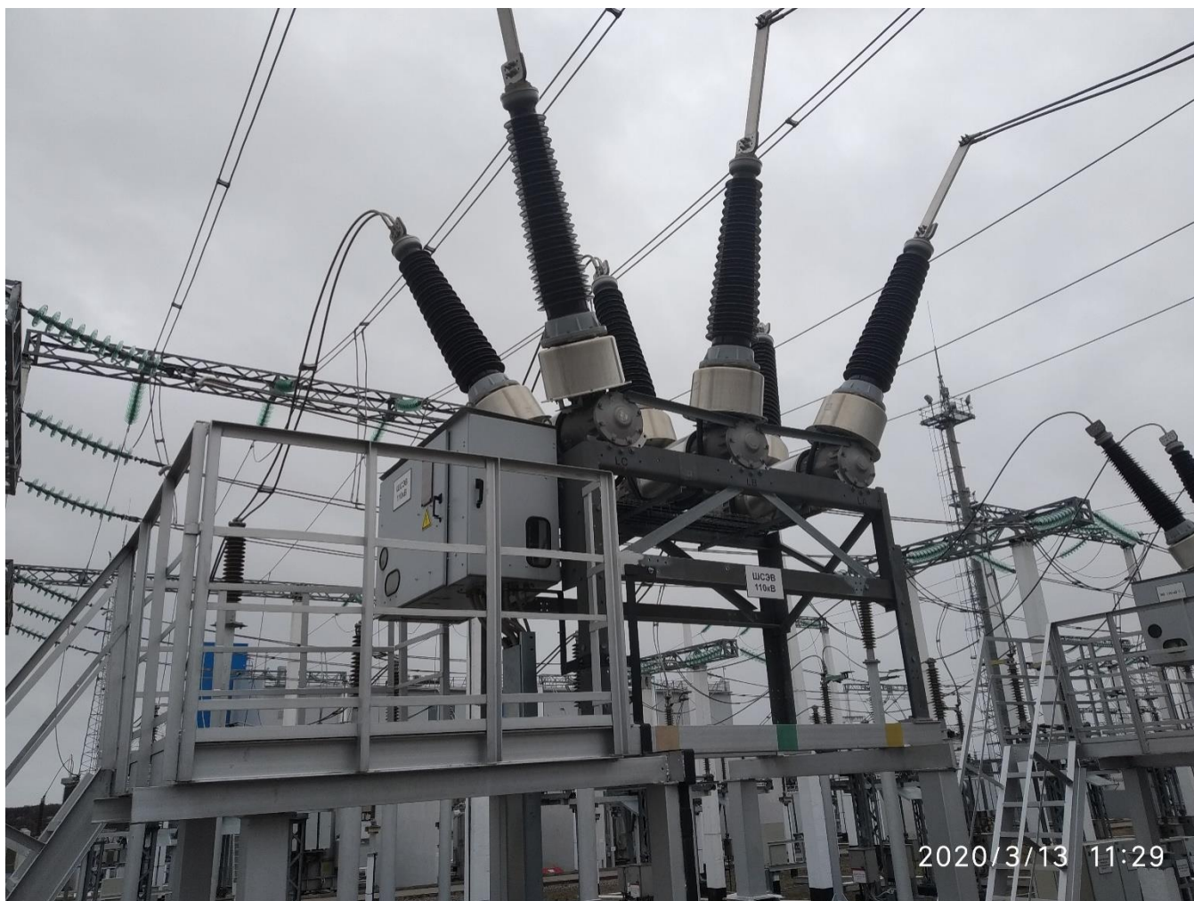
Рисунок 8 – ОРУ-110 кВ, элегазовые выключатели напряжением 110 кВ
