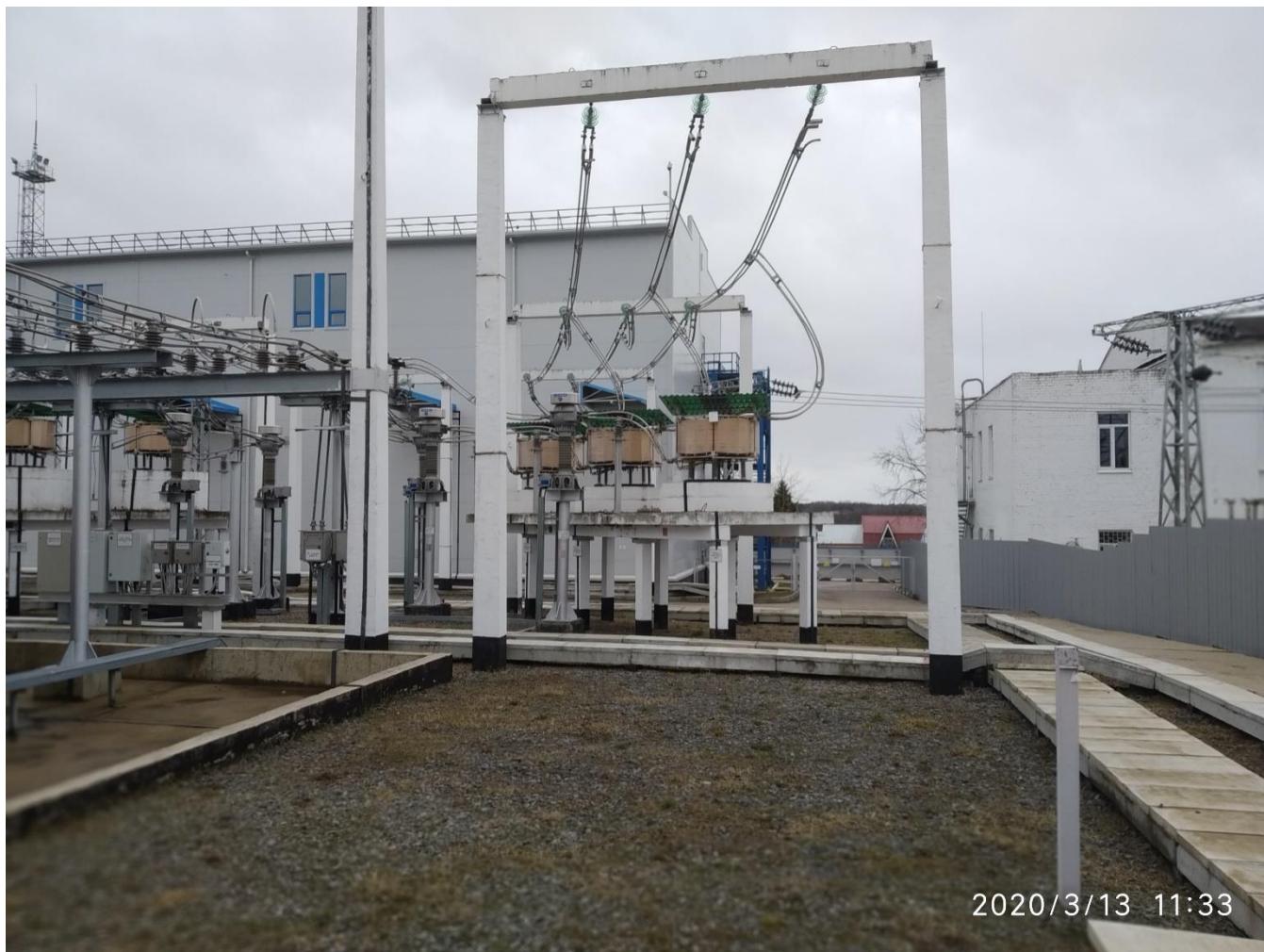
Рисунок 9 – Токоограничивающие трехфазные реакторы 10 кВ (4 шт.)
