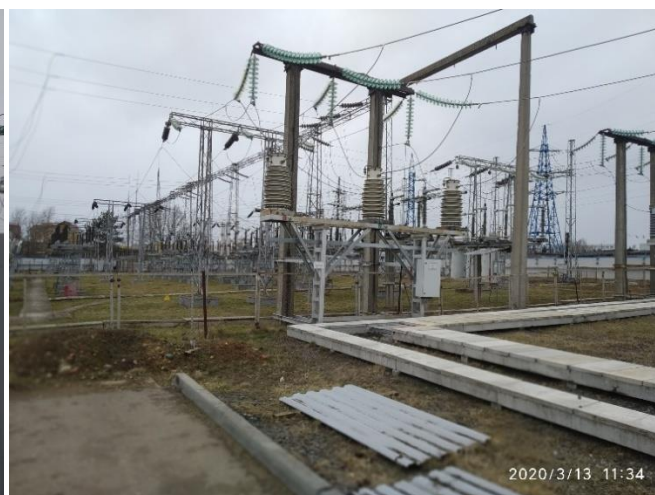
Рисунок 10 – старое ОРУ-110 кВ, демонтаж основного оборудования
