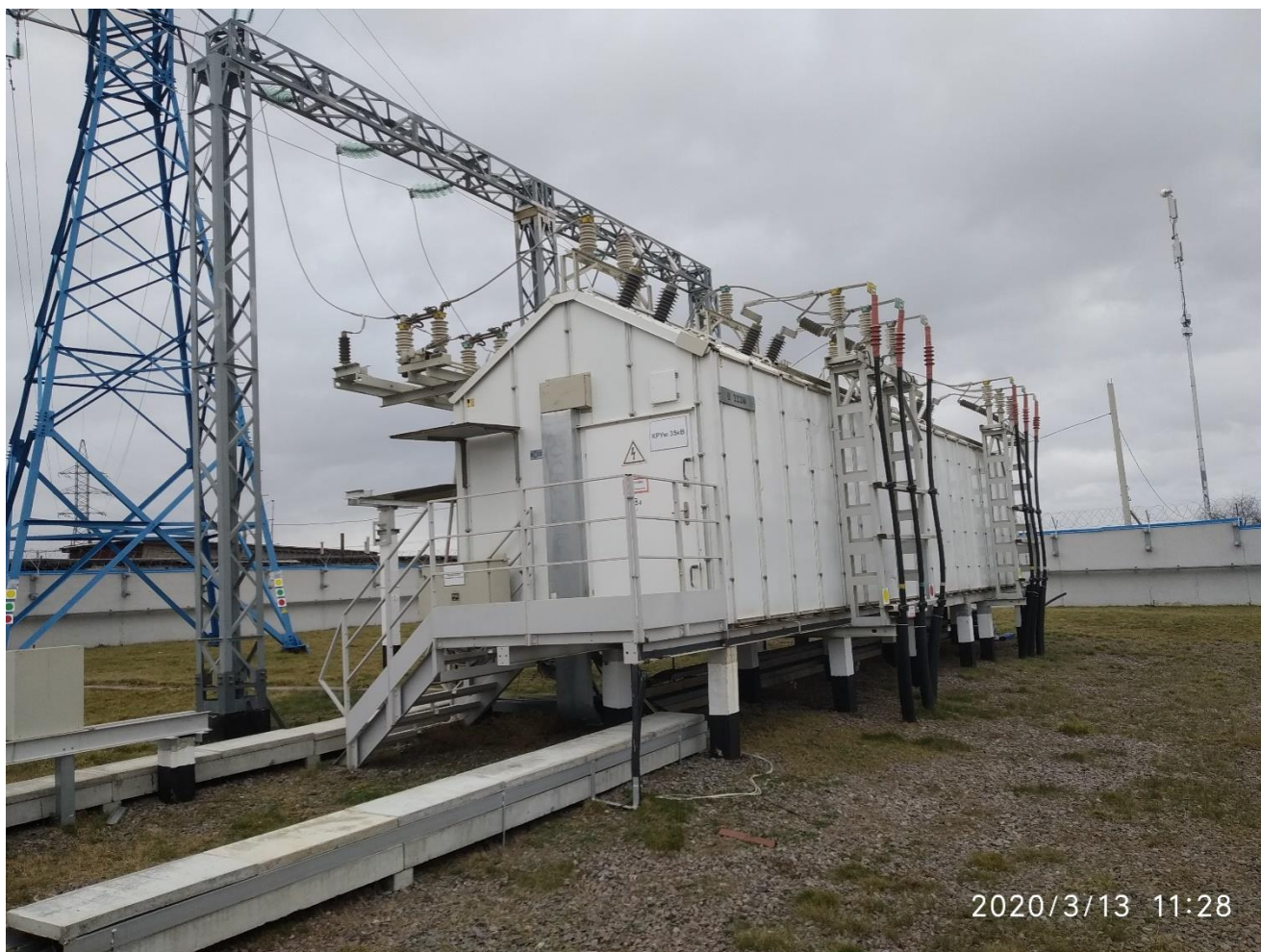
Рисунок 5 – КРУМ-35 кВ, портал и отходящая ВЛ 35 кВ
