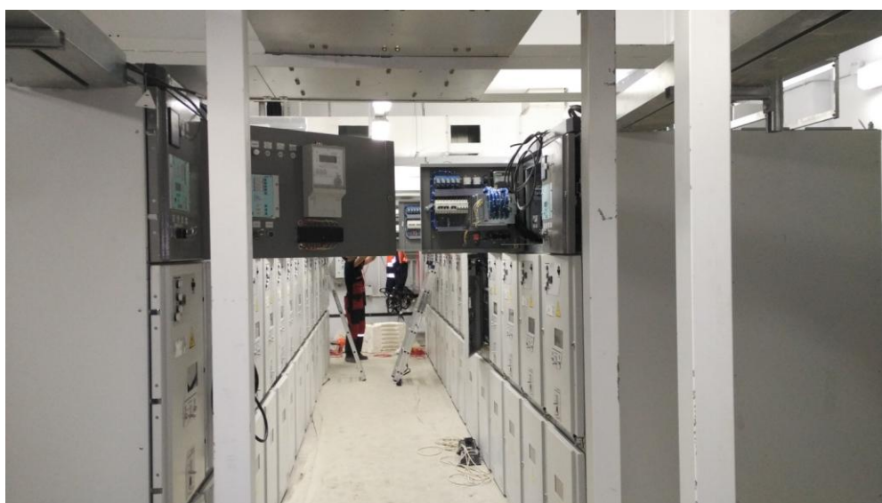
Рис. 6.4. Ячейки КРУ 10 кВ.
