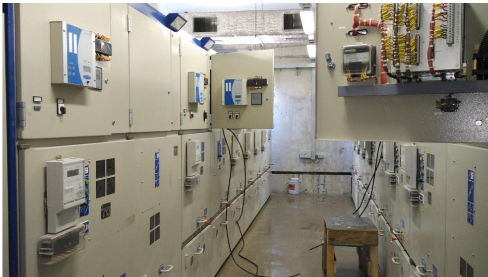
Рис. 6.6. Ячейки КРУ 20 кВ.
