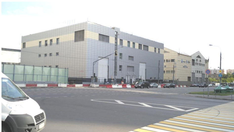
Рис. 6.1. Общий вид ПС 220/20/10 кВ Белорусская.
