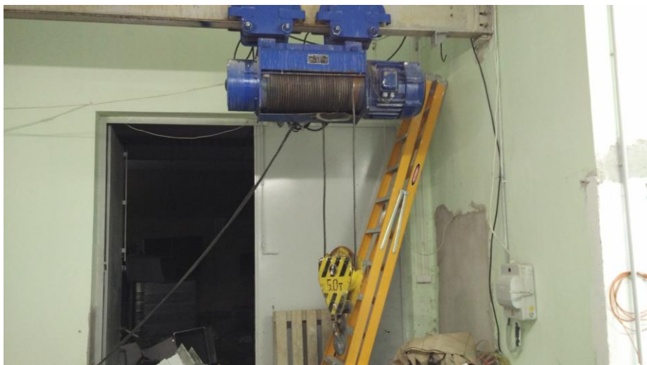
Рис. 6.14. Электроталь в коридоре.
