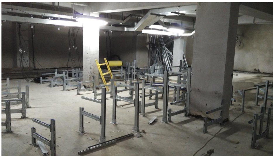
Рис. 6.8. Расстановка кабельных конструкций в кабельном подвале.
