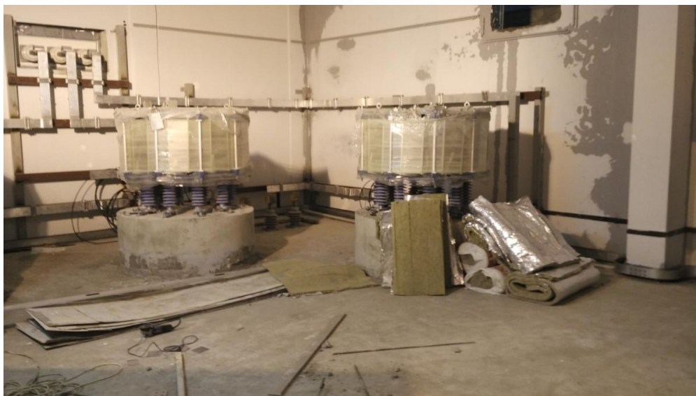
Рис. 6.5. Токоограничивающие реакторы 10 кВ.
