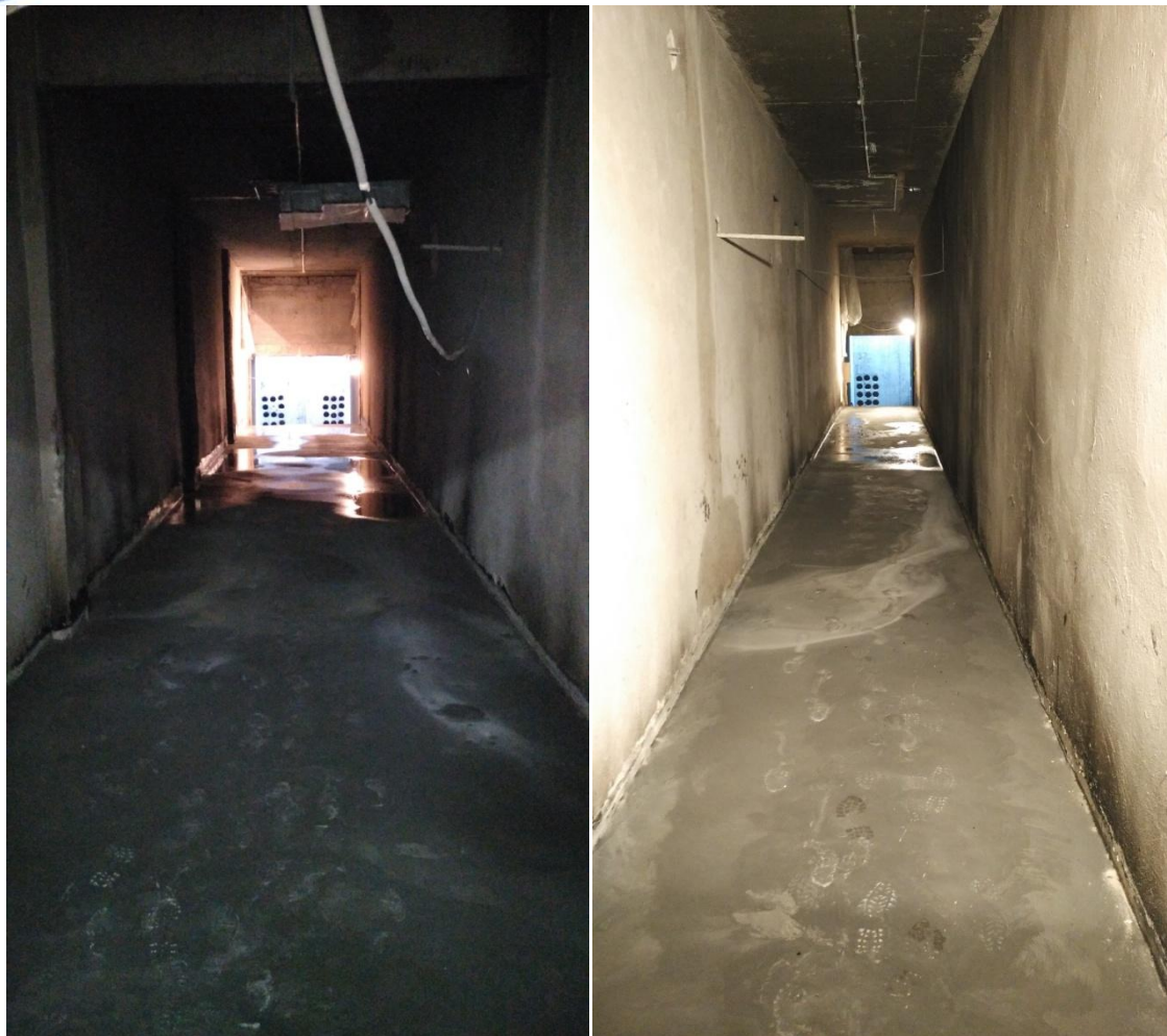
Рис. 6.12. Кабельные тоннели для кабельных линий 10-20 кВ
