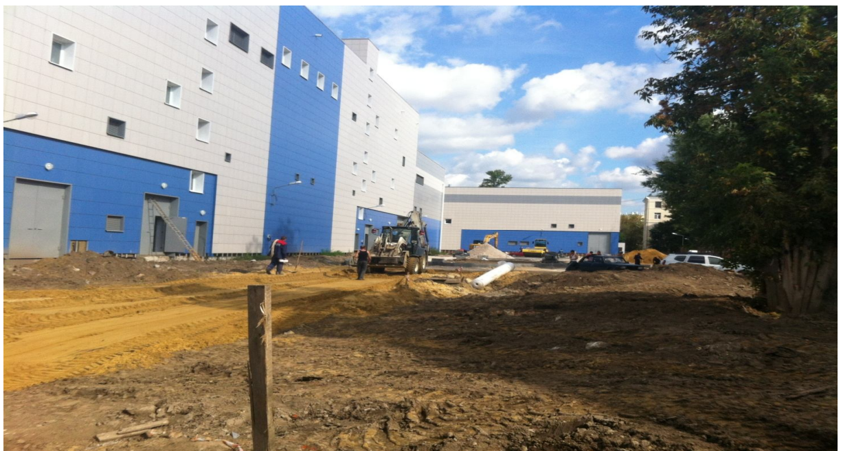
Рис. 6.1. Здание закрытой подстанции и здание КРУЭ 220 кВ
