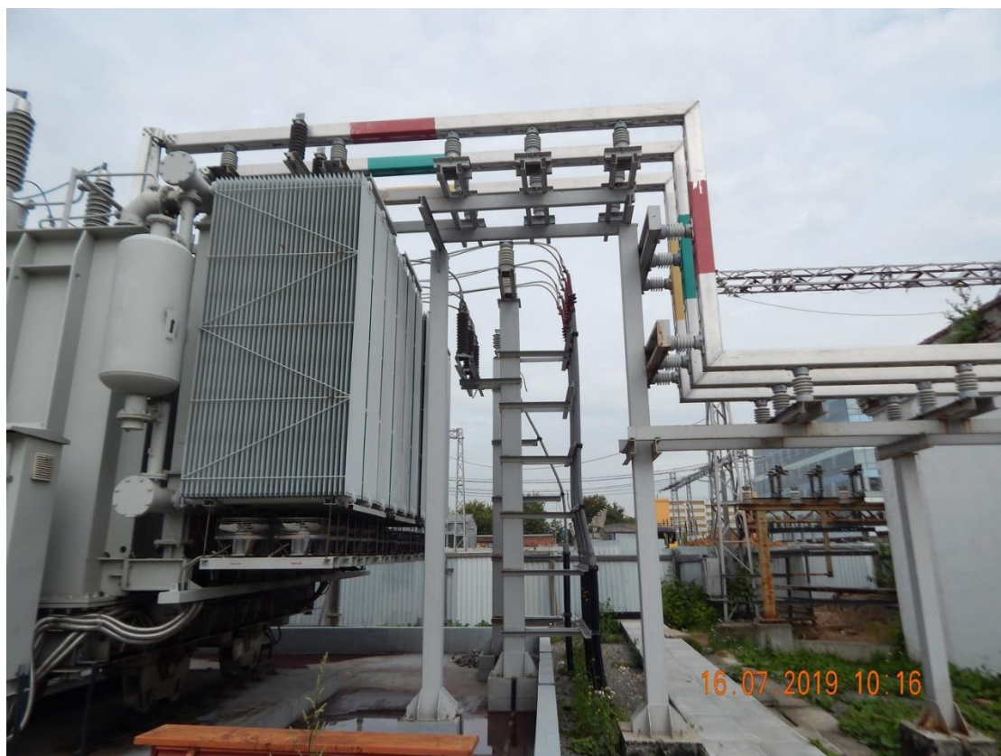
Рисунок 6 – Включенное положение нейтрали трансформаторов Т-6 и Т-7
