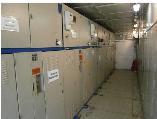
Рисунок 7 – КРУЭ 35 кВ (ячейки секций 35 кВ)
