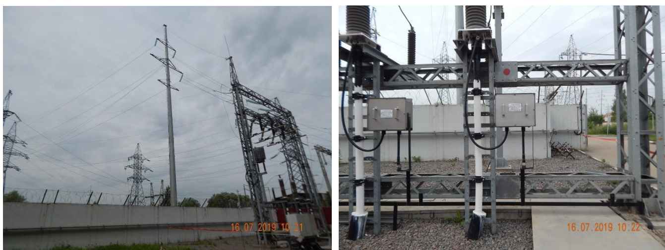
Рисунок 11 – Новые присоединения ВЛ 110 кВ
