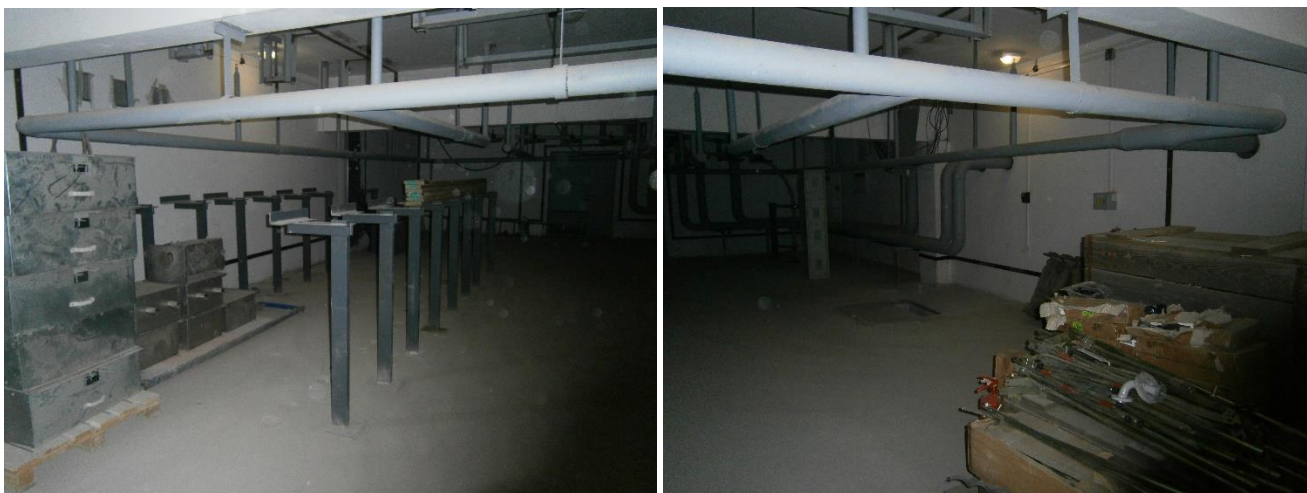
Рисунок 3 – Кабельный полуэтаж секций КРУ-10 кВ
