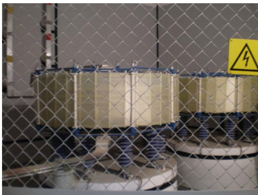
Рисунок 9 – Токоограничивающие реакторы 10 кВ (4 шт.) в здании КРУЭ-110 кВ
