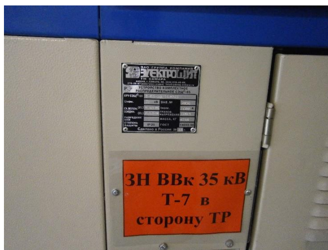
Рисунок 7 – КРУЭ 35 кВ (ячейки секций 35 кВ)
