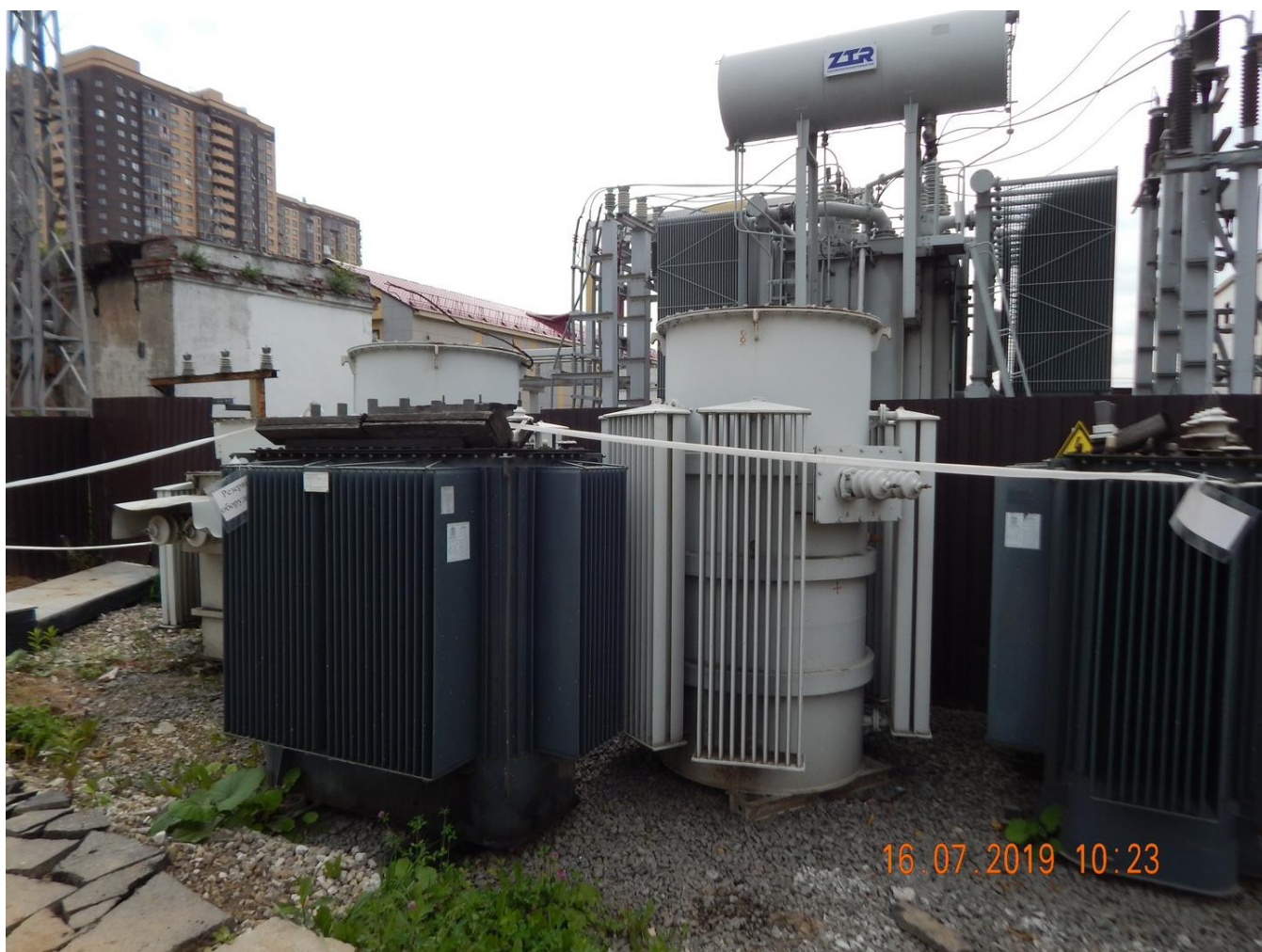
Рисунок 12 – Демонтированное оборудования на ОРУ-110 кВ (Т-1, Т-2 и Т-3)
