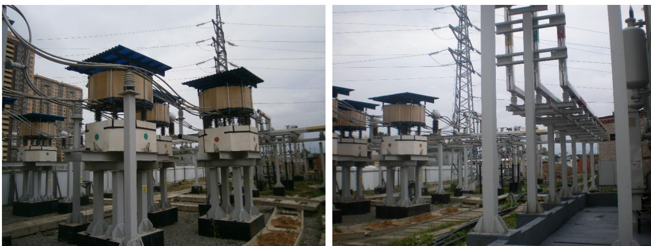
Рисунок 10 – Токоограничивающие реакторы 6 кВ (4 шт.) – открытая установка
