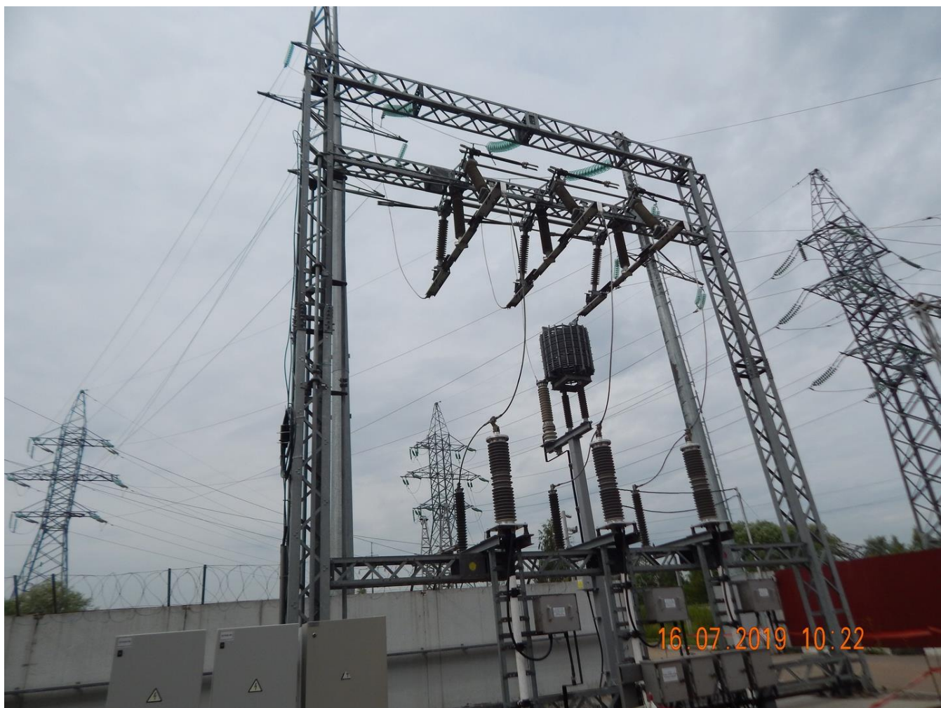
Рисунок 11 – Новые присоединения ВЛ 110 кВ
