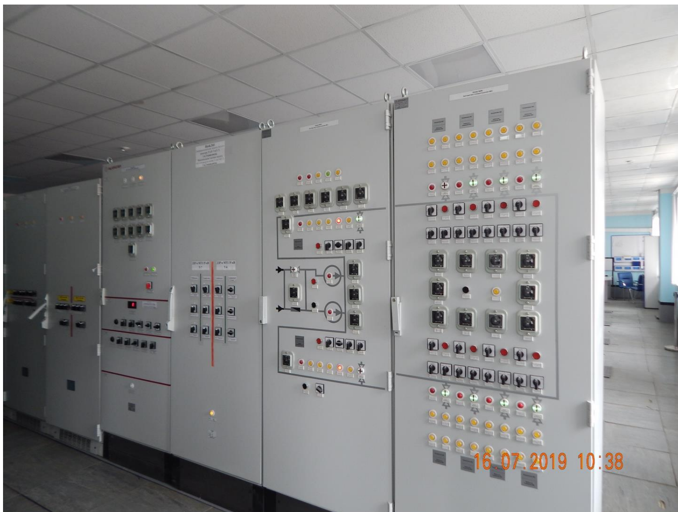
Рисунок 5 – Релейный зал (панели ОПУ, мнемосхема)
