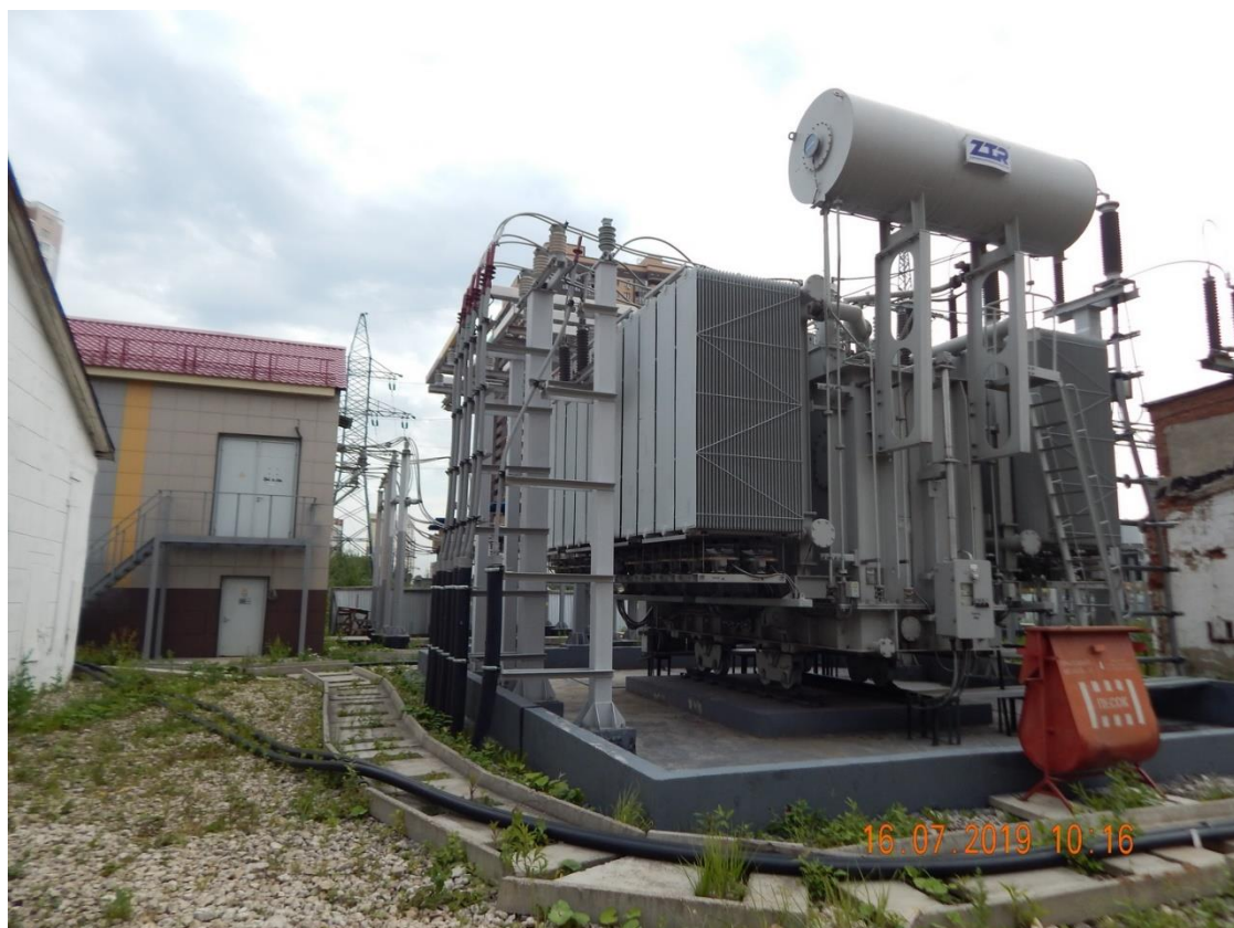
Рисунок 6 – Включенное положение нейтрали трансформаторов Т-6 и Т-7
