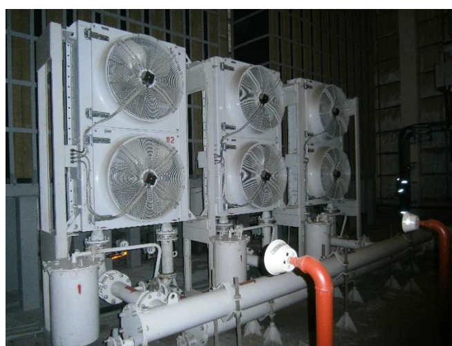
Рисунок 2 – Камера трансформатора Т-5 (Т-4) 1100/10-10 кВ по 63 МВА каждый
