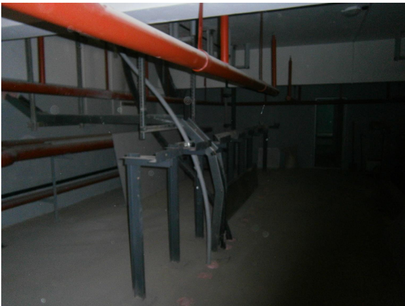
Рисунок 3 – Кабельный полуэтаж секций КРУ-10 кВ
