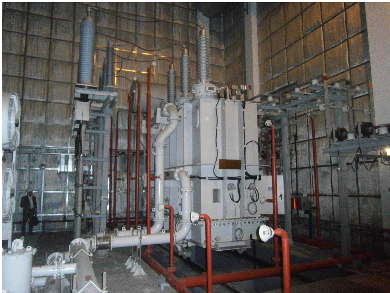
Рисунок 2 – Камера трансформатора Т-5 (Т-4) 1100/10-10 кВ по 63 МВА каждый
