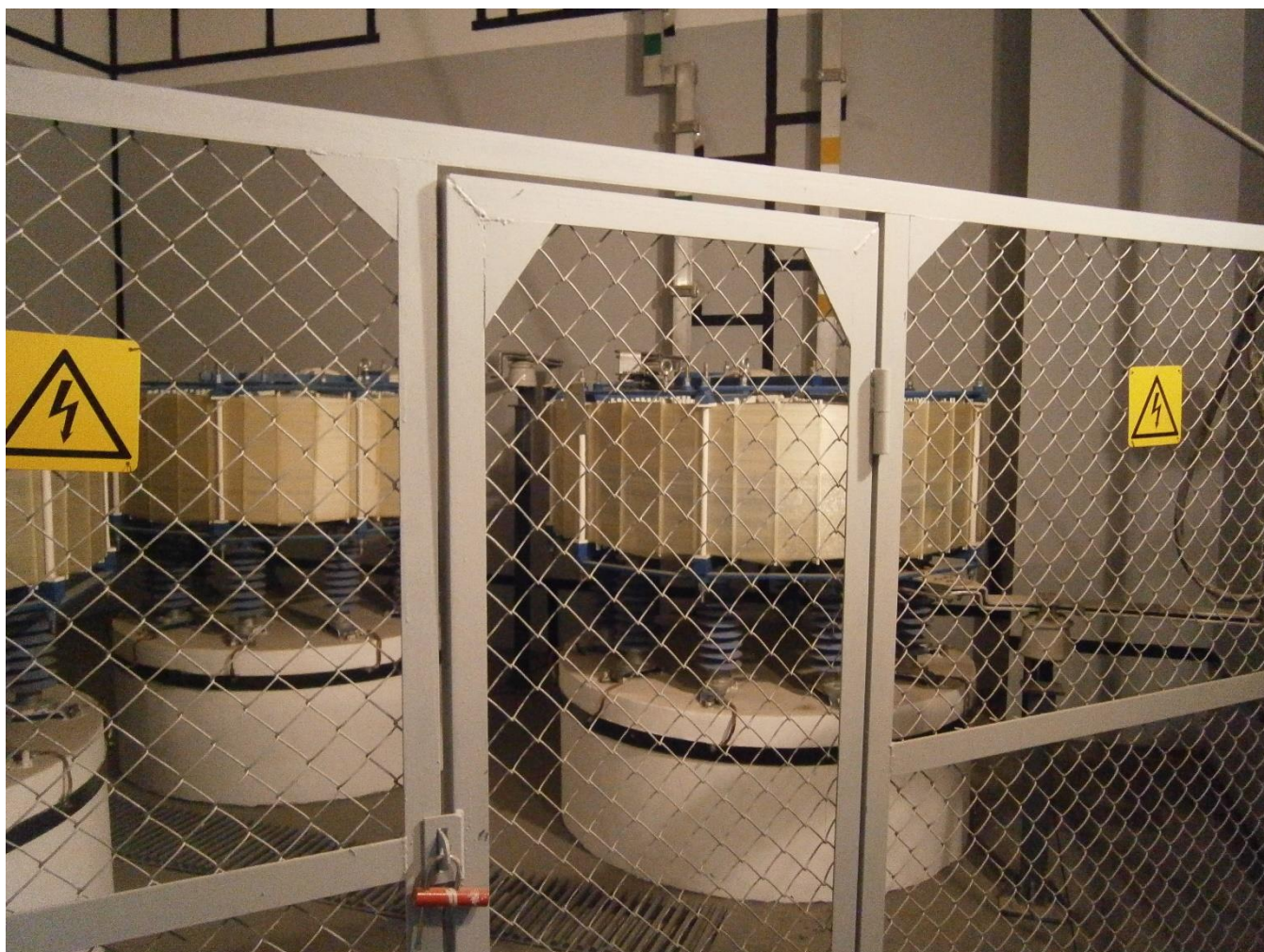
Рисунок 9 – Токоограничивающие реакторы 10 кВ (4 шт.) в здании КРУЭ-110 кВ
