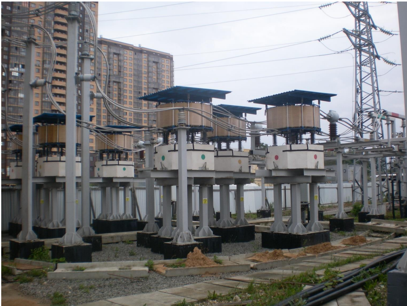
Рисунок 10 – Токоограничивающие реакторы 6 кВ (4 шт.) – открытая установка
