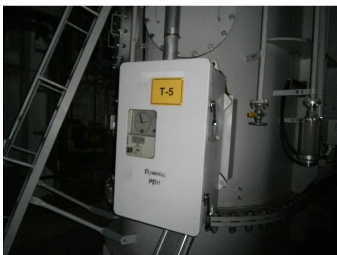
Рисунок 2 – Камера трансформатора Т-5 (Т-4) 1100/10-10 кВ по 63 МВА каждый
