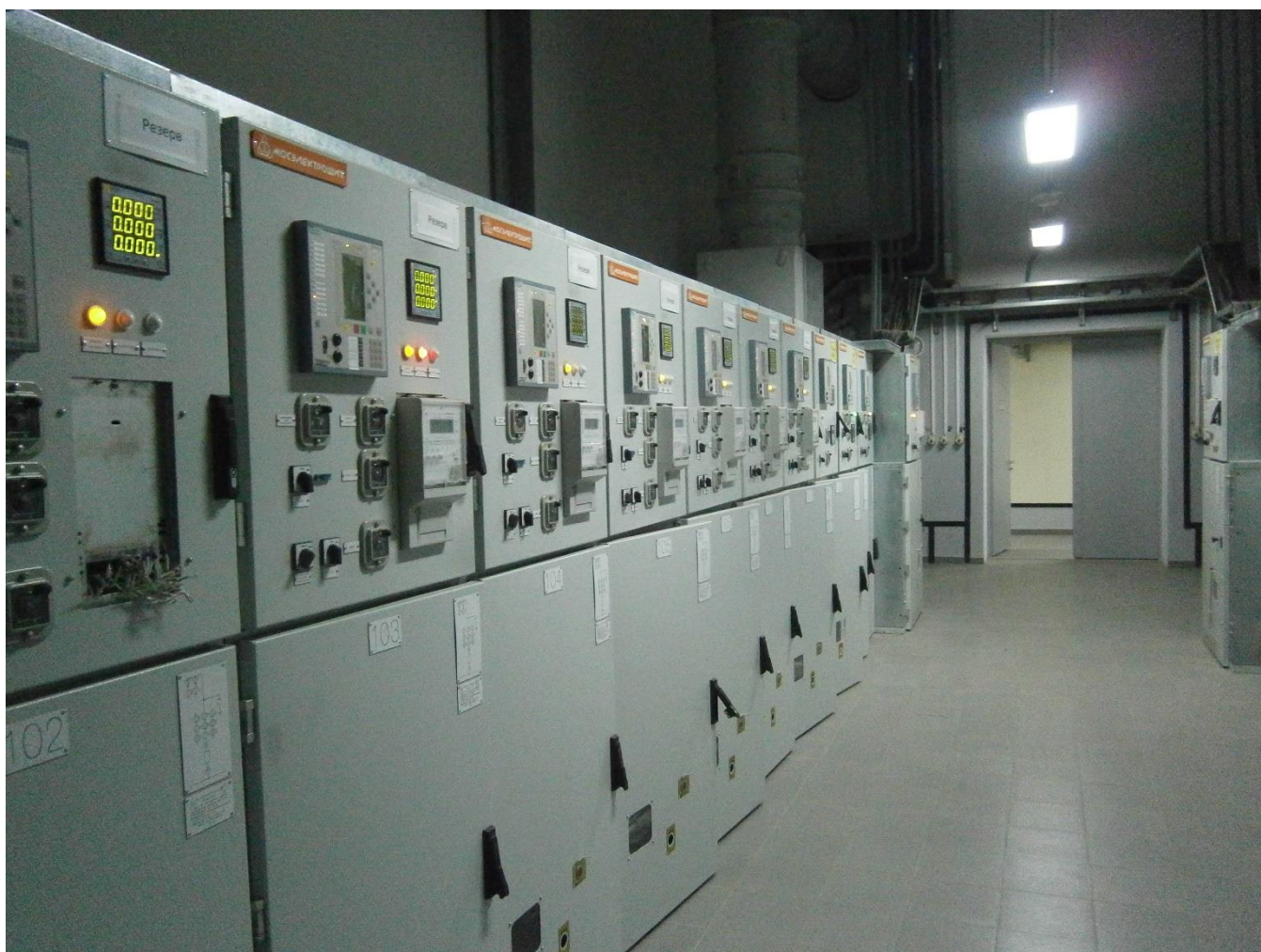
Рисунок 4 – КРУ 10 кВ (ячейки секции 1-3/ 2-4)
