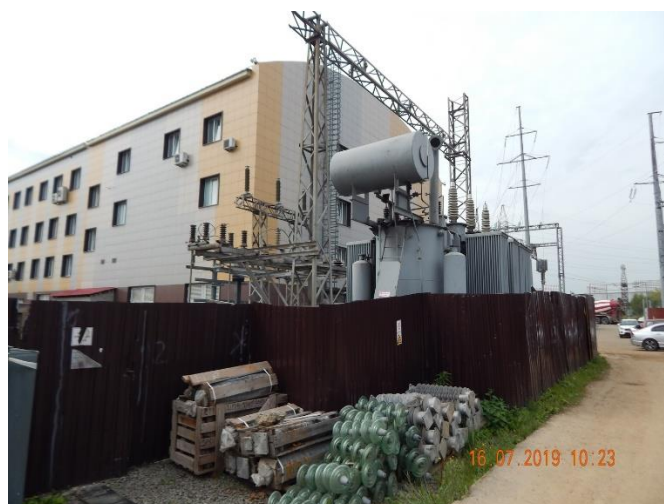
Рисунок 12 – Демонтированное оборудования на ОРУ-110 кВ (Т-1, Т-2 и Т-3)
