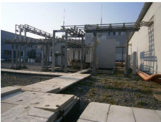
Рисунок 8 – Регулировочные трансформаторы 63 МВА (4 шт.) напряжением 10 кВ
