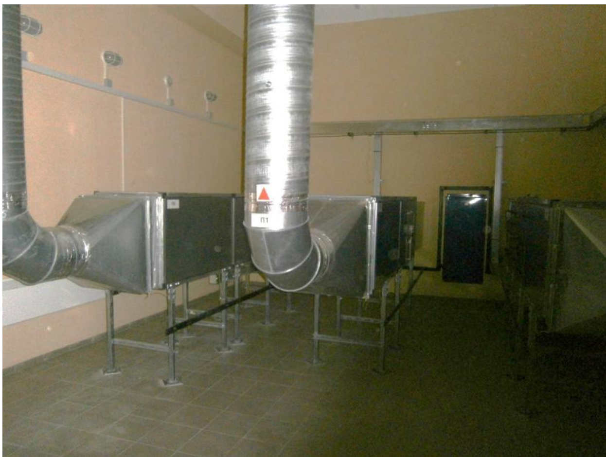
Рисунок 7 – Камера вытяжной вентиляции
