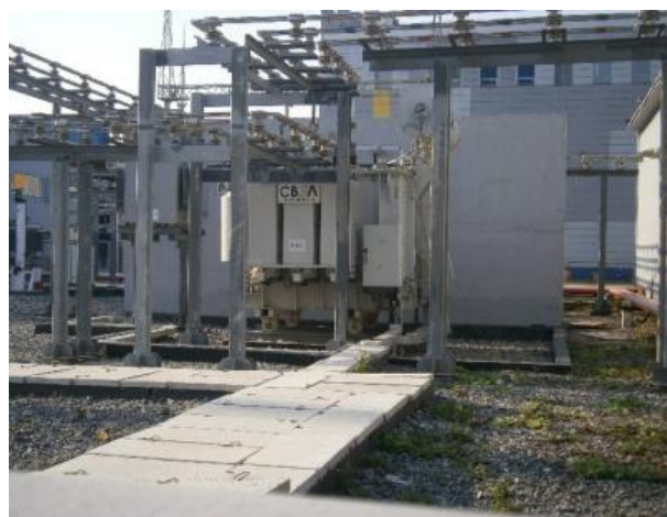
Рисунок 8 – Регулировочные трансформаторы 63 МВА (4 шт.) напряжением 10 кВ
