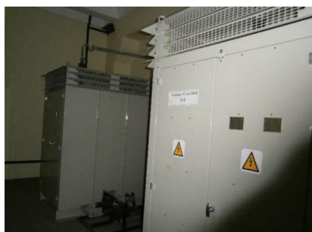
Рисунок 5 – Кабельный полуэтаж 1-3 секции КРУ-20 кВ и камера резисторов 20 кВ
