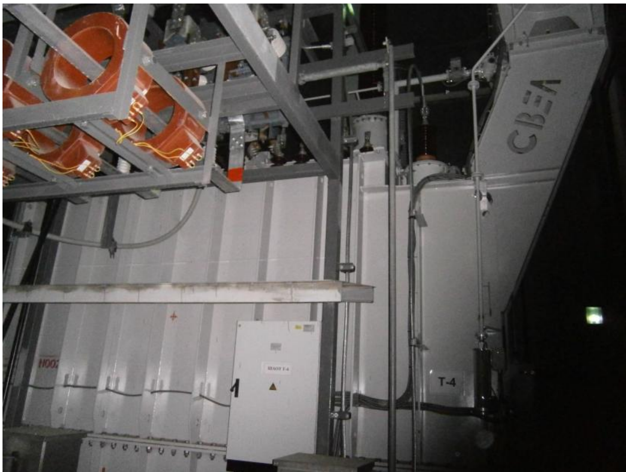
Рисунок 2 – Камера трансформатора Т-4 (Т-3) 220/20-20 кВ по 100 МВА каждый
