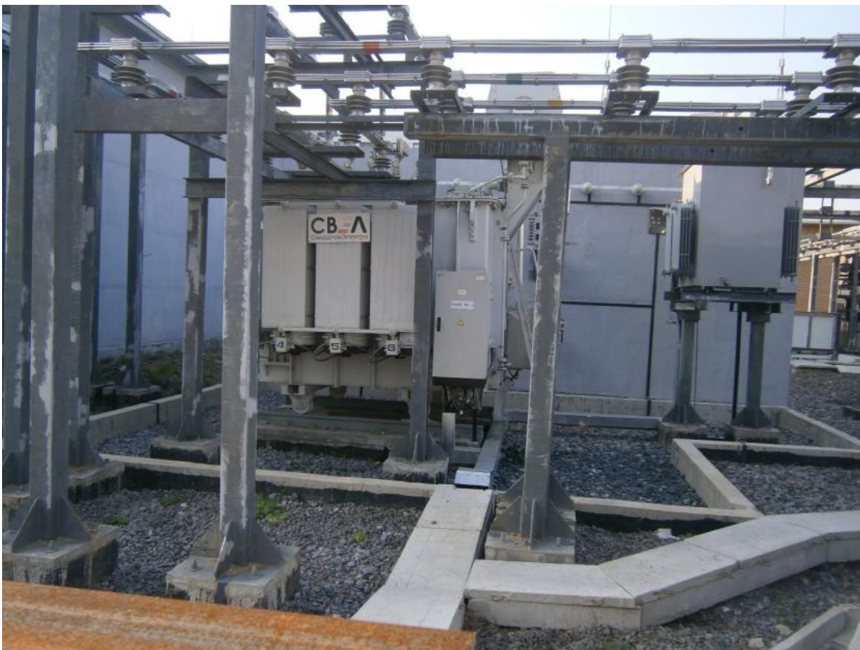
Рисунок 8 – Регулировочные трансформаторы 63 МВА (4 шт.) напряжением 10 кВ
