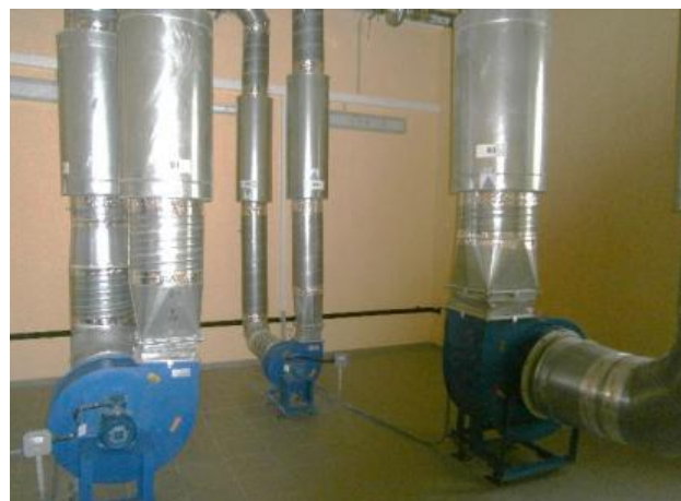
Рисунок 7 – Камера вытяжной вентиляции
