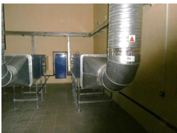
Рисунок 7 – Камера вытяжной вентиляции
