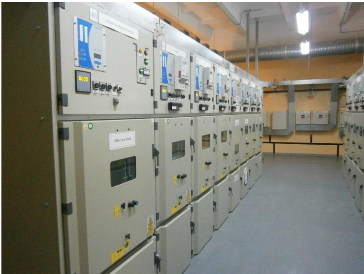
Рисунок 6 – КРУ 20 кВ (ячейки секции 1-3/ 2-4)
