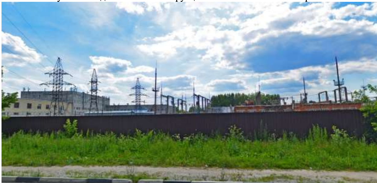
Рисунок 2. Вид объекта Реконструкция ПС 110 кВ № 419 Минеральная.
