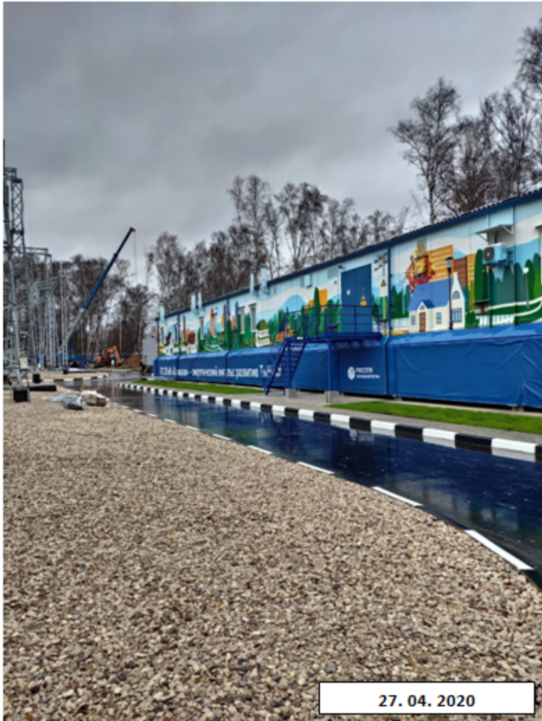
Здание ЗРУ-20 кВ с ОПУ
