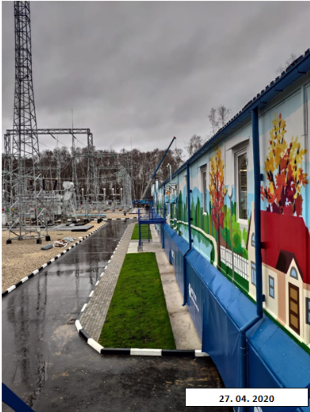
Благоустройство возле здания ЗРУ-20 кВ с ОПУ
