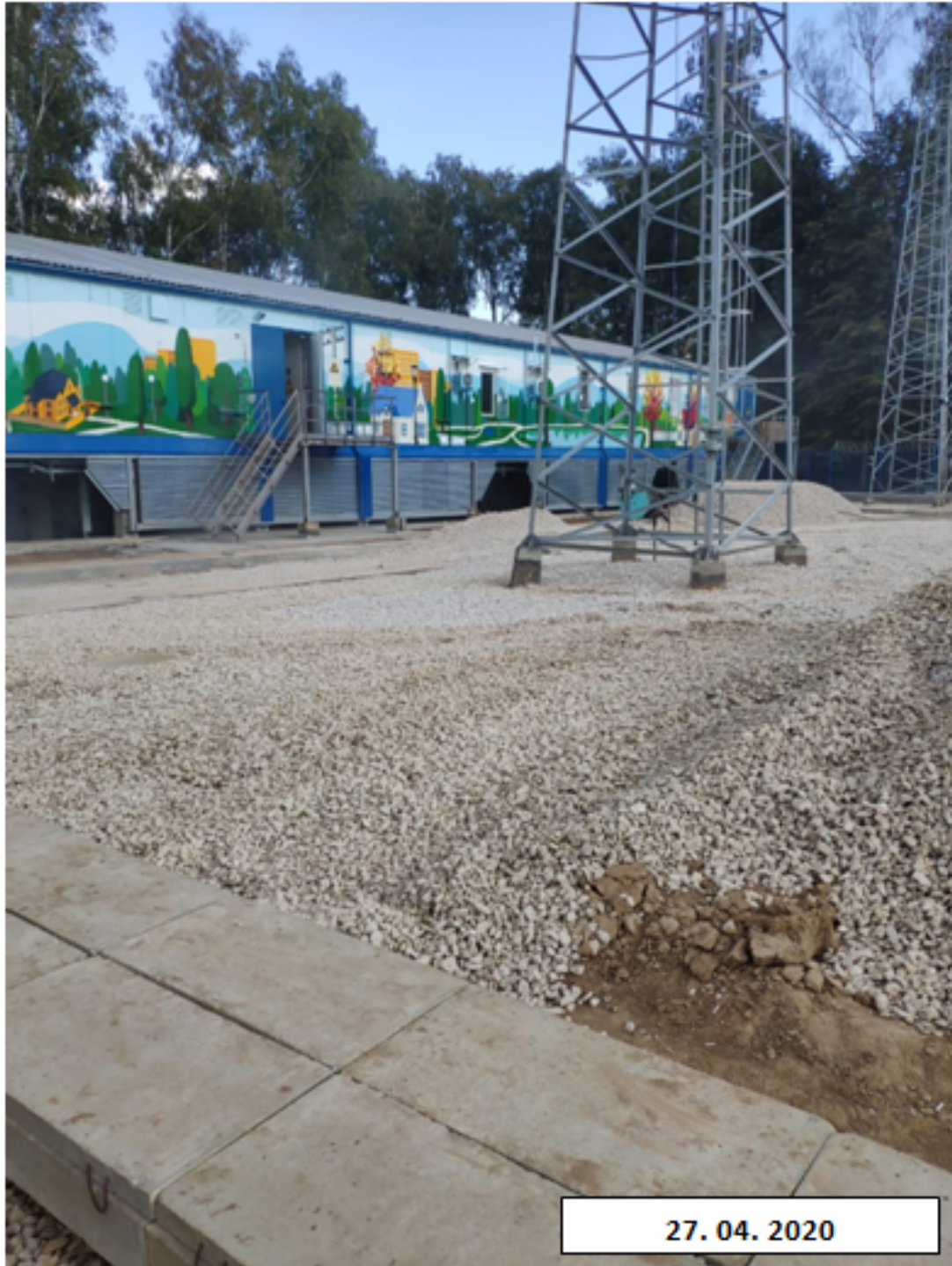
Здание ЗРУ-20 кВ с ОПУ
