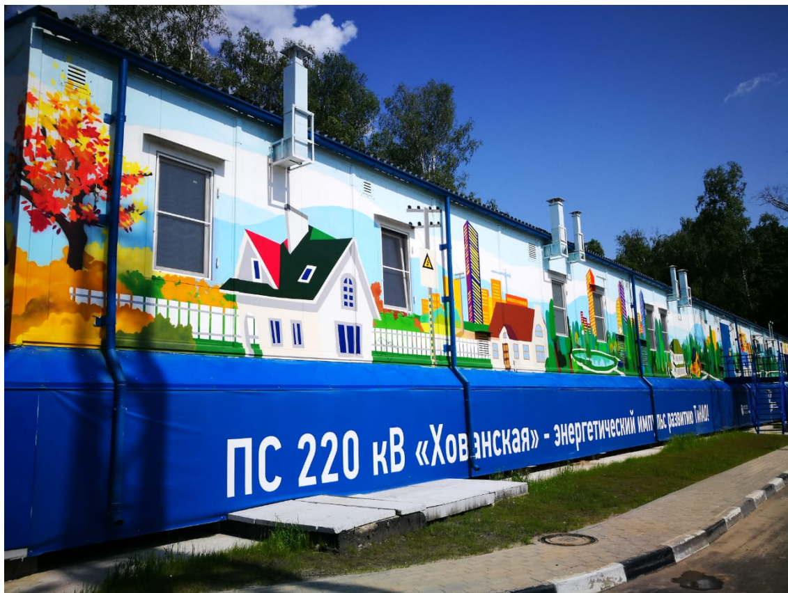
Здание ЗРУ-20 кВ с ОПУ
