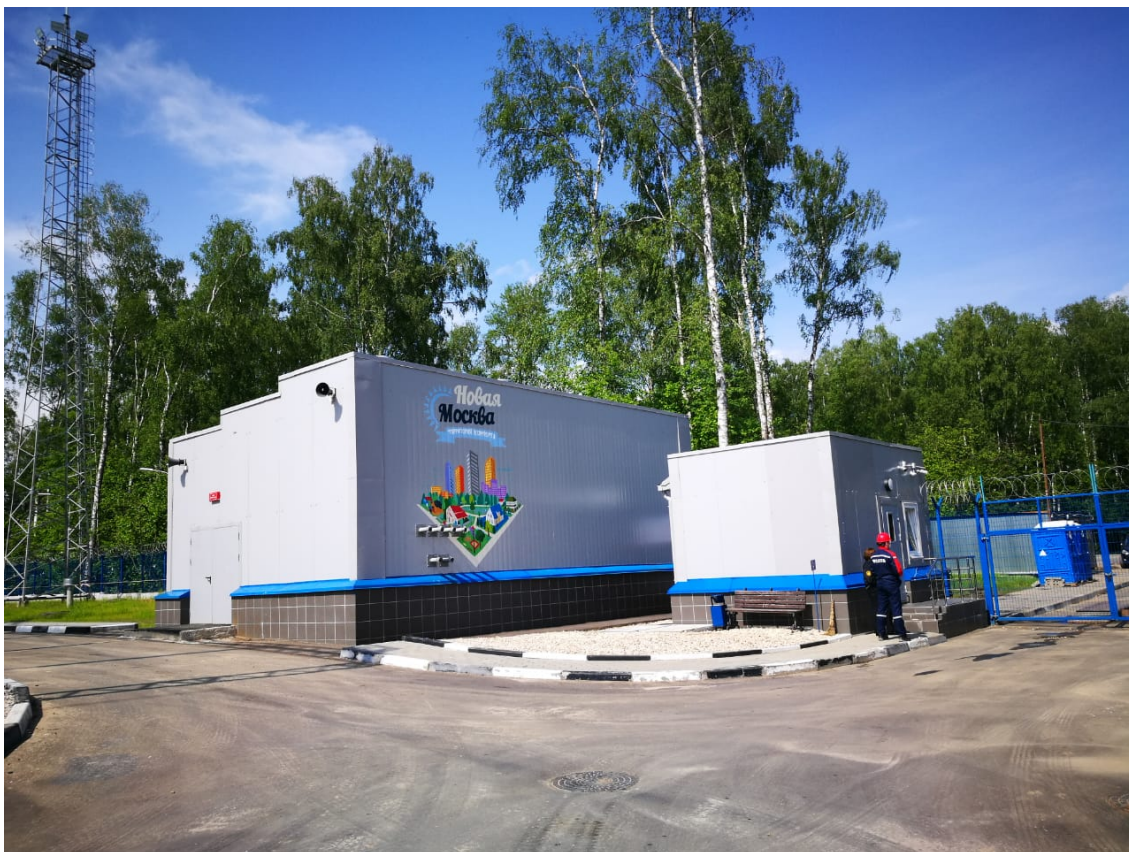
Насосная станция и здание КПП
