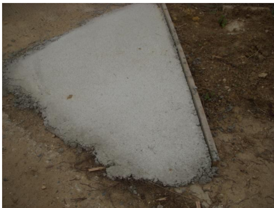
Рисунок 6-29. Бетонированный участок внутриплощадочной дороги.
