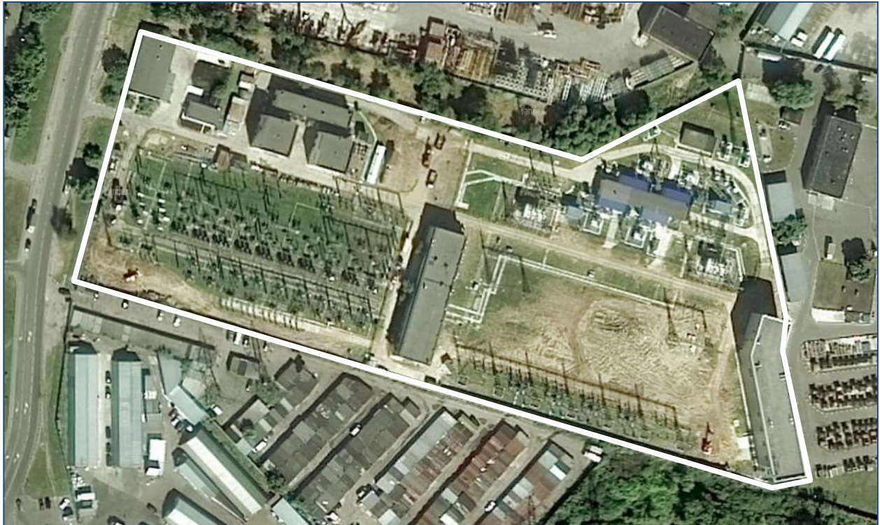
Рисунок 2-1. Подстанция №370 "Чертаново" (© DigitalGlobe, 2014).
