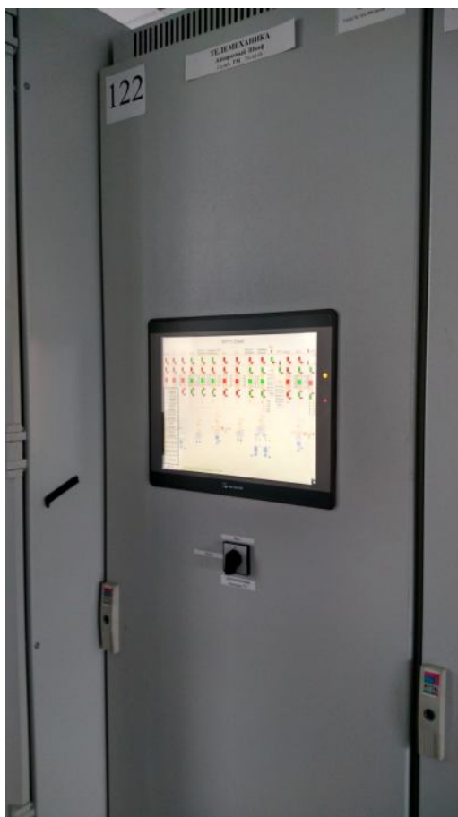
Рисунок 6-12. Оборудование телемеханики.
