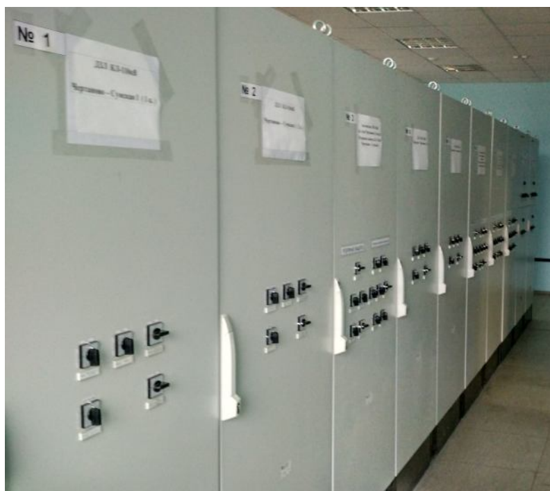
Рисунок 6-13. Панели РЗА.
