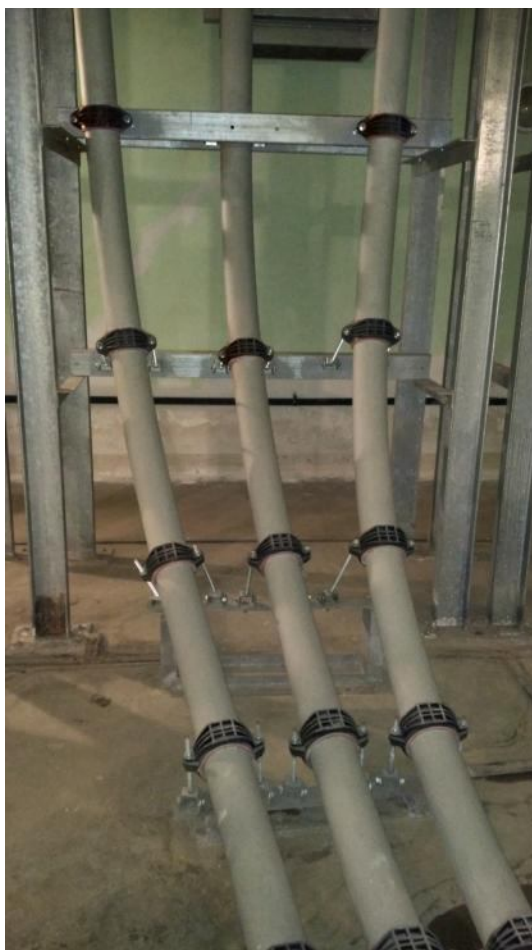
Рисунок 6-6. Смонтированные кабельные линии 220 кВ.
