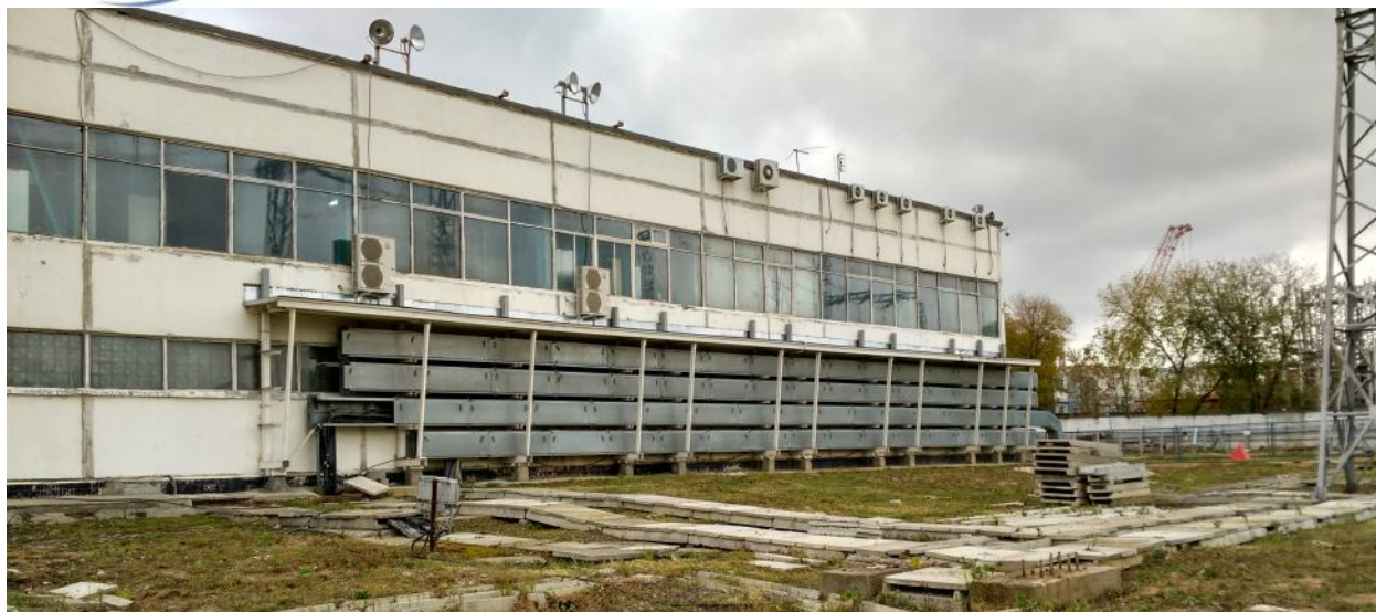
Рисунок 6-16. Трассы кабелей 0,4 кВ, вынесенные из зоны демонтажа ОРУ 220 кВ на внешнюю стену существующего здания ОПУ.
