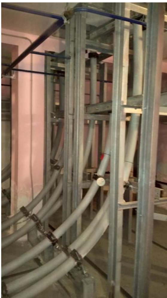
Рисунок 6-5. Смонтированные кабельные линии 110 кВ.
