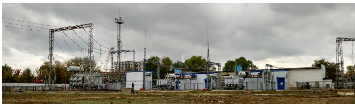
Рисунок 6-15. Установка автотрансформаторов 220/110 кВ и ЗРУ-10 кВ.
