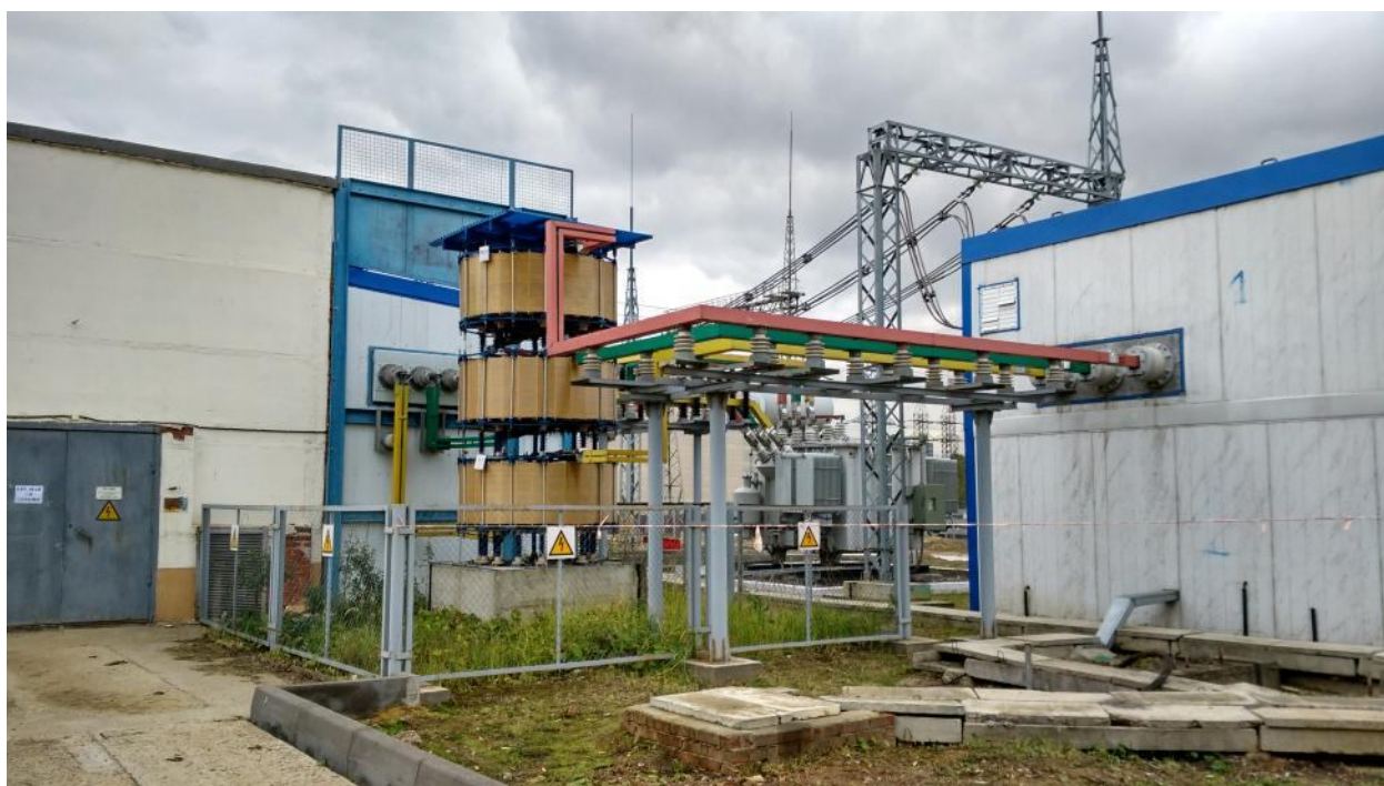
Рисунок 6-23. Токоограничивающий реактор 10 кВ.
