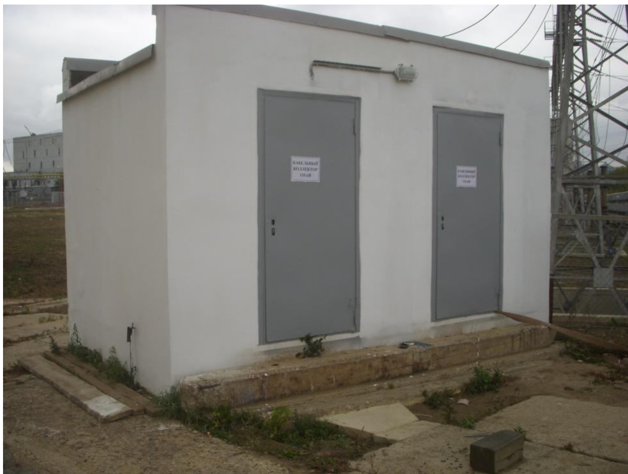
Рисунок 6-19. Вход к кабельные туннели 110 кВ с венткиоском.
