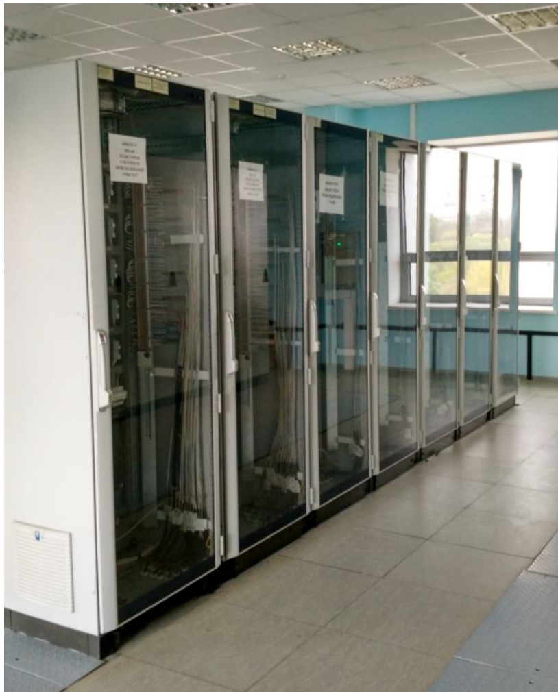
Рисунок 6-14. Панели АИИС КУЭ.
