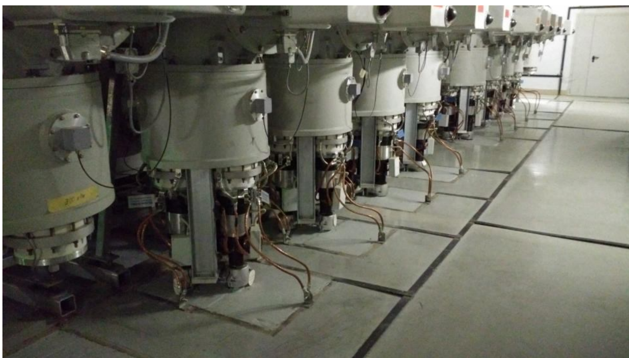
Рисунок 6-7. Кабельные вводы в КРУЭ 110 кВ.
