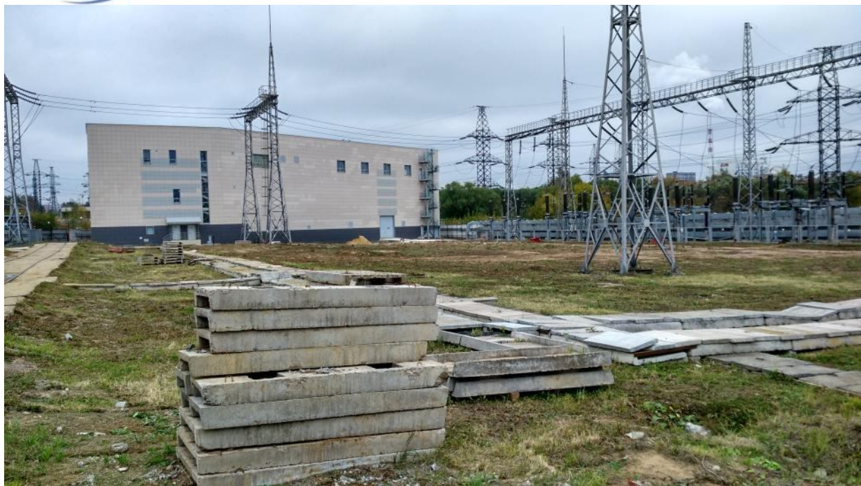
Рисунок 6-1. Здание КРУЭ 220/110 кВ.
