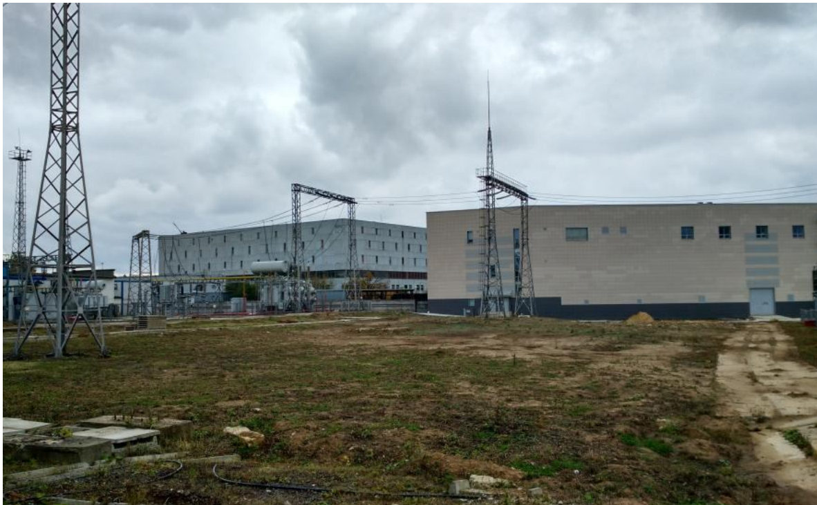
Рисунок 6-27. Площадка демонтированного ОРУ 220 кВ под монтаж трансформаторов 220/20 кВ Т-5 и Т-6 .
