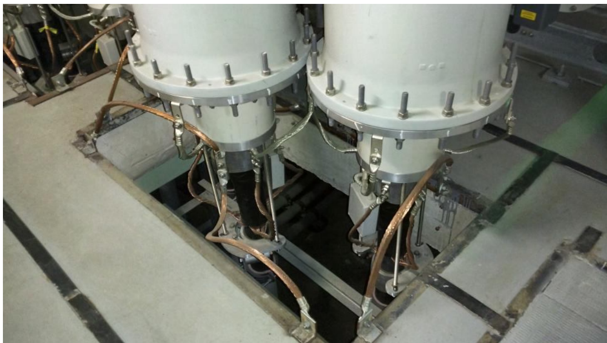
Рисунок 6-8. Кабельные вводы в КРУЭ 220 кВ.
